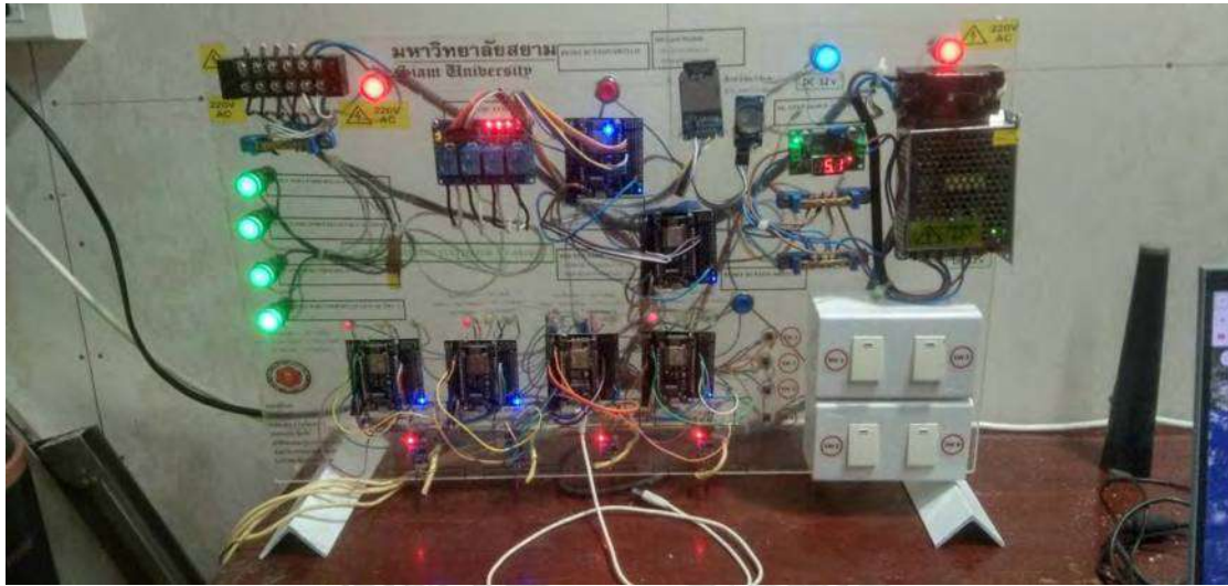
รูปที่ 2.8 อุปกรณ์ของระบบควบคุมการจ่ายน้ำในสวนอัจฉริยะ
