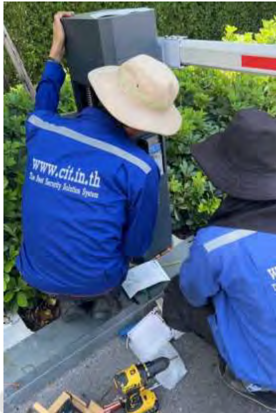
รูปที่ 4.13 ติดตั้งตู้ไม้กั้น
