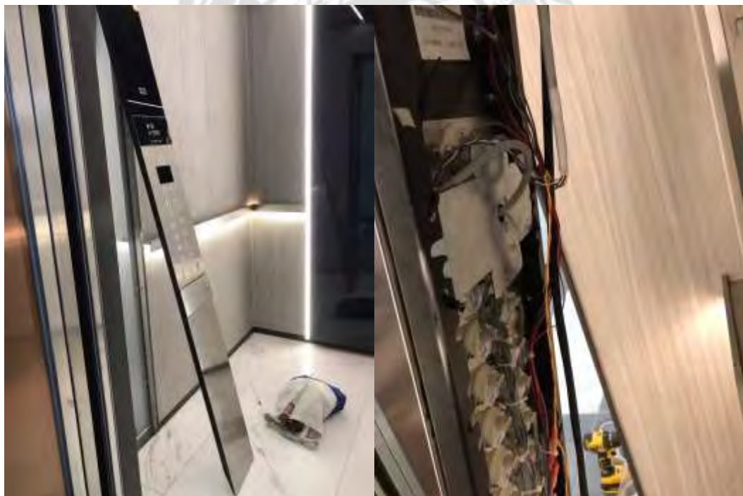
รูปที่ 4.16 ติดตั้งหัวอ่านคีย์การ์ดลิฟท์
