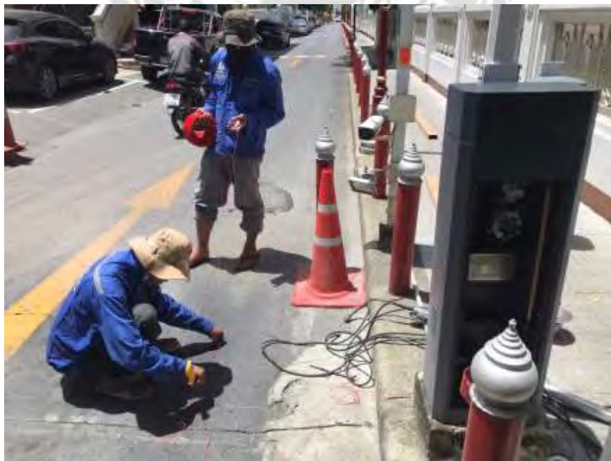
รูปที่ 4.10 กรีดถนนเพื่อติดตั้งลูบ
