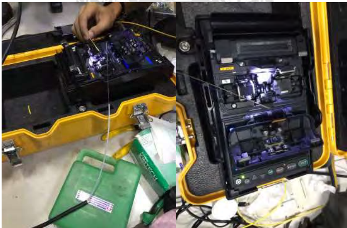
รูปที่ 4.12 เชื่อมสายไฟเบอร์ออฟติก
