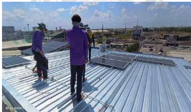
รูปที่ 4.15 ขั้นตอนการวางแผงโซล่าเซลล์
