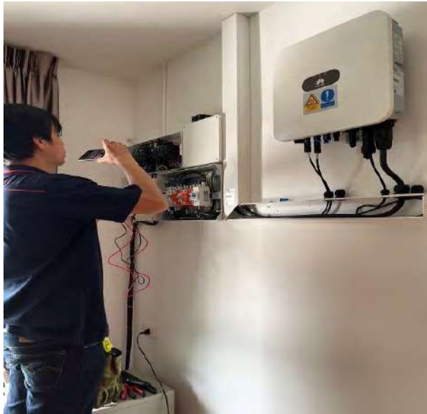
รูปที่ 4.17 ขั้นตอนการติดตั้งเครื่องอินเวอร์เตอร์
