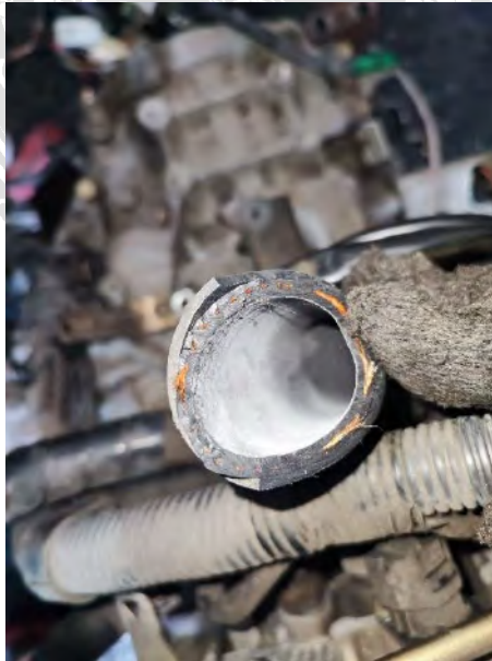
รูปที่ 4.4 เซ็ทคราบสนิมที่ทางเดินน้ำหล่อเย็น
