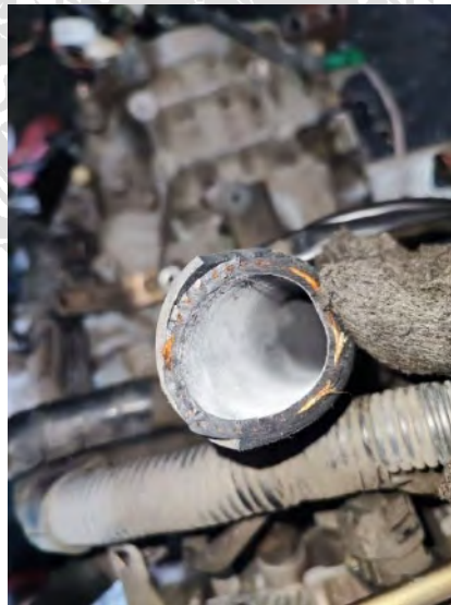
รูปที่ 3.9 เช็คคราบสนิมที่ทางเดินน้ำหล่อเย็น
