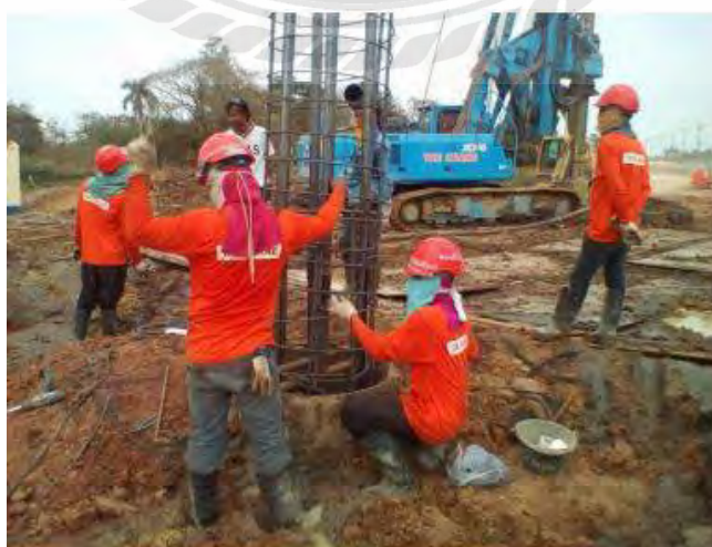
ภาพที่ 4-8 แสดงการติดตั้งเหล็กเสริม
