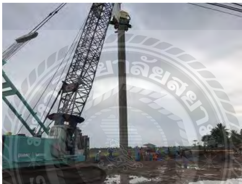
ภาพที่ 4-13 การถอนปลอกเหล็กออกจากหลุมเจาะ
