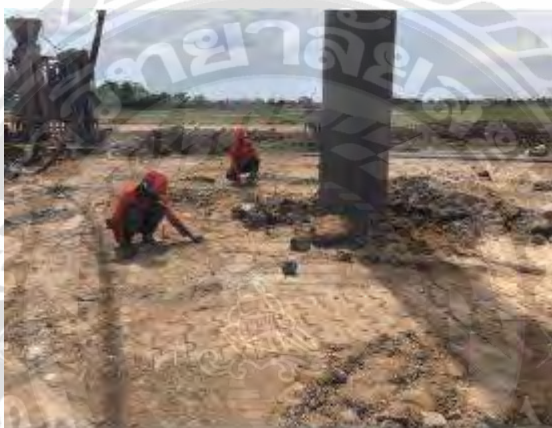
ภาพที่ 4-4 การควบคุมไม่ให้ปลอกเหล็กเบี่ยงเบน
