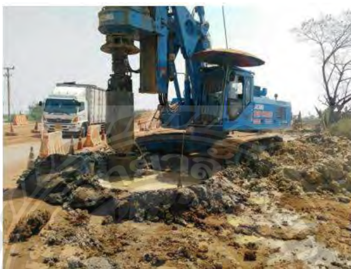
ภาพที่ 4-7 การใช้เครื่องจักรติดตั้งถังทำความสะอาดหลุมเจาะ (Cleaning Bucket)
