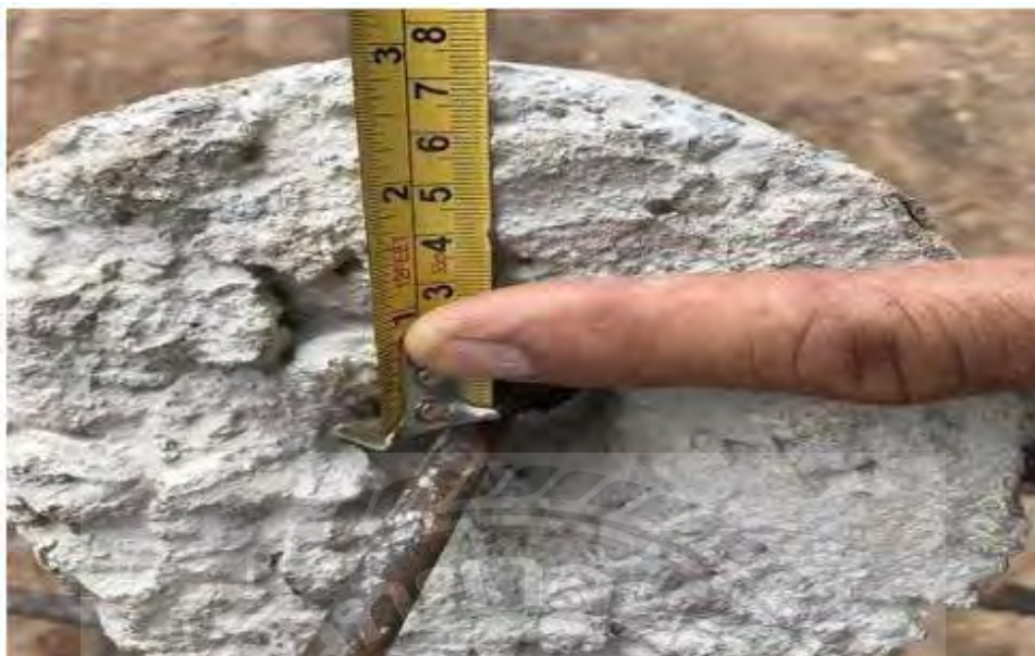
ภาพที่ 4-9 ลูกปุ่นระยะหุ้มคอนกรีต
