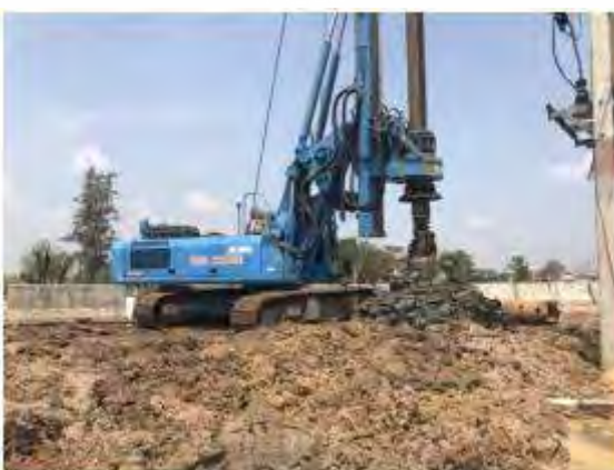
ภาพที่ 4-5 การเจาะเสาเข็ม
