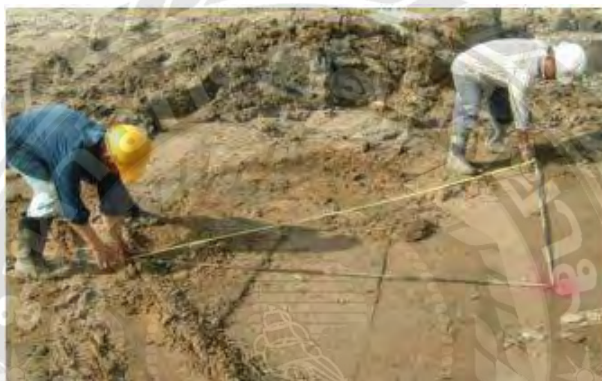
ภาพที่ 4-2 ช่างสำรวจกำหนดตำแหน่งเสาเข็ม
