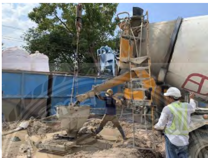
ภาพที่ 4-11 การเทคอนกรีต
