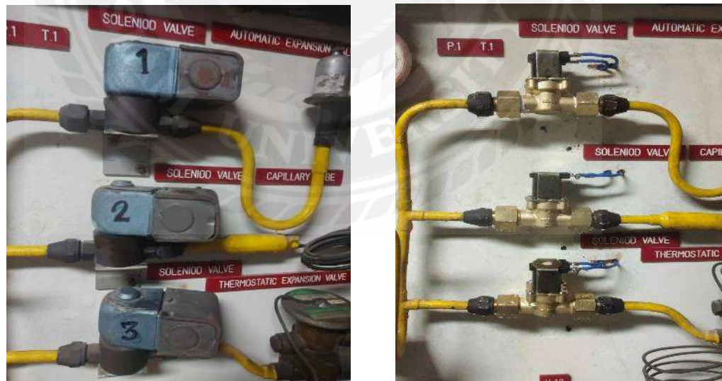
รูปที่ 3.4 รูปก่อนและหลังการซ่อมแซมโซลินอยด์
