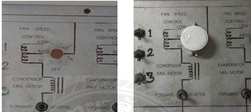
รูปที่ 3.5 รูปก่อนและหลังการซ่อมแซมสวิทช์พัดลม
