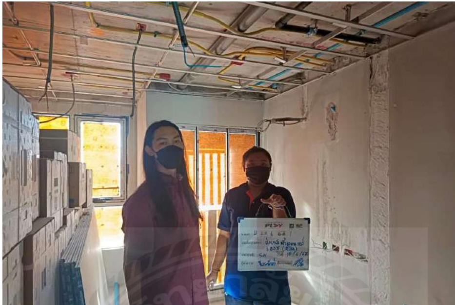
รูปภาพผนวกที่ 5 ส่งงานทดสอบน้ำที่ห้องเครื่อง
