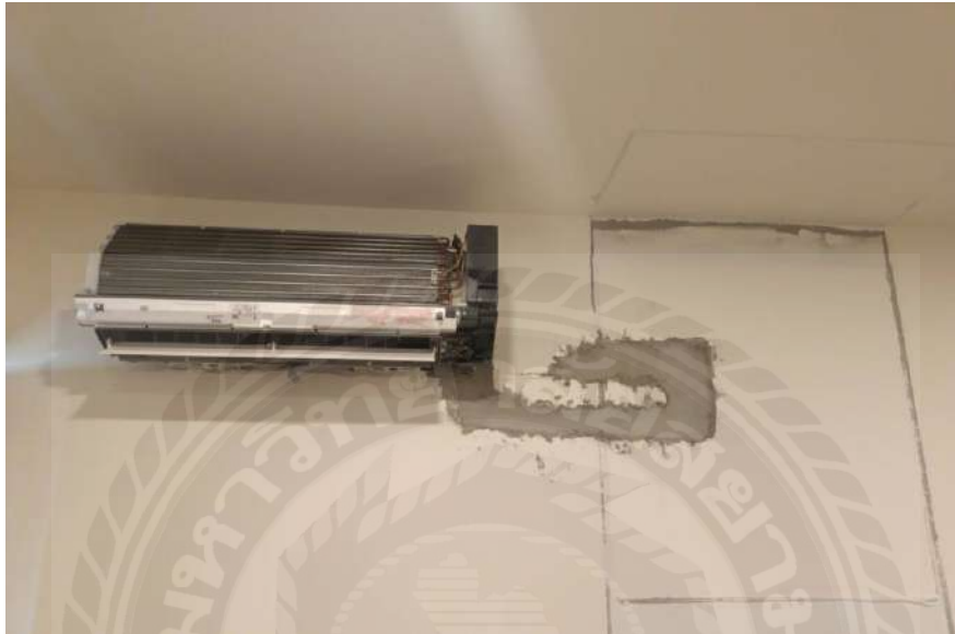
รูปที่ 4.31 ขณะตรวจงานแก้ไขท่อน้ำทิ้งเดรนแอร์
