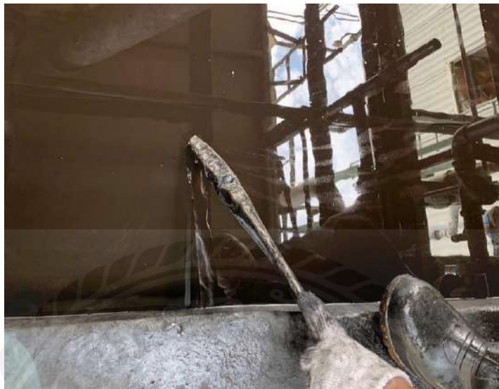
รูปที่ 3.10 การตูดน้ำมันลอยหน้าจากบ่อน้ำหล่อเย็น
