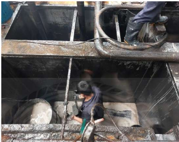
รูปที่ 3.8 บ่อน้ำหล่อเย็น
