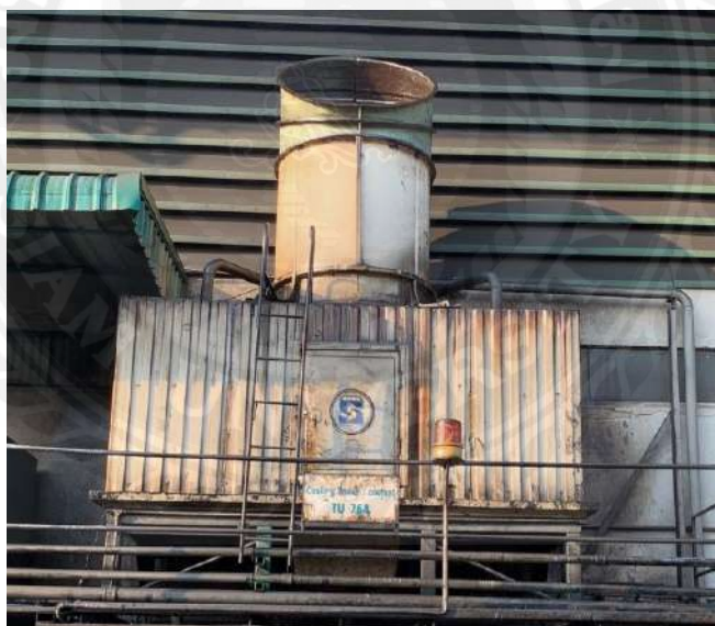
รูปภาคผนวกที่ 8 Cooling Tower ของเครื่องจักร TU-76A
