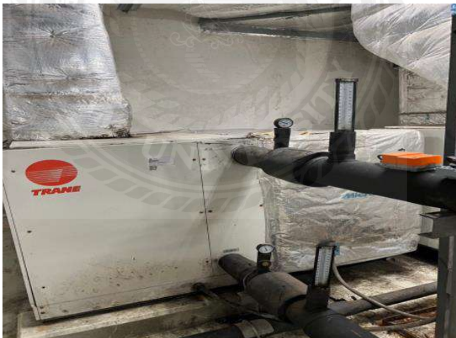
รูปภาพผนวก ที่ 8 ตรวจสอบเกจวัดแรงดันน้ำ
