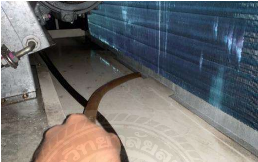
รูปที่ 3.14 ใช้โบลเวอร์ดูด ตะกอน ในถาดเตรน
