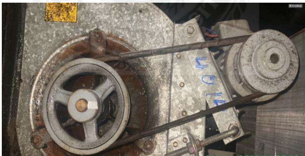
รูปที่ 3.16 ตรวจสอบเช็คสายพานและมู่เล่
