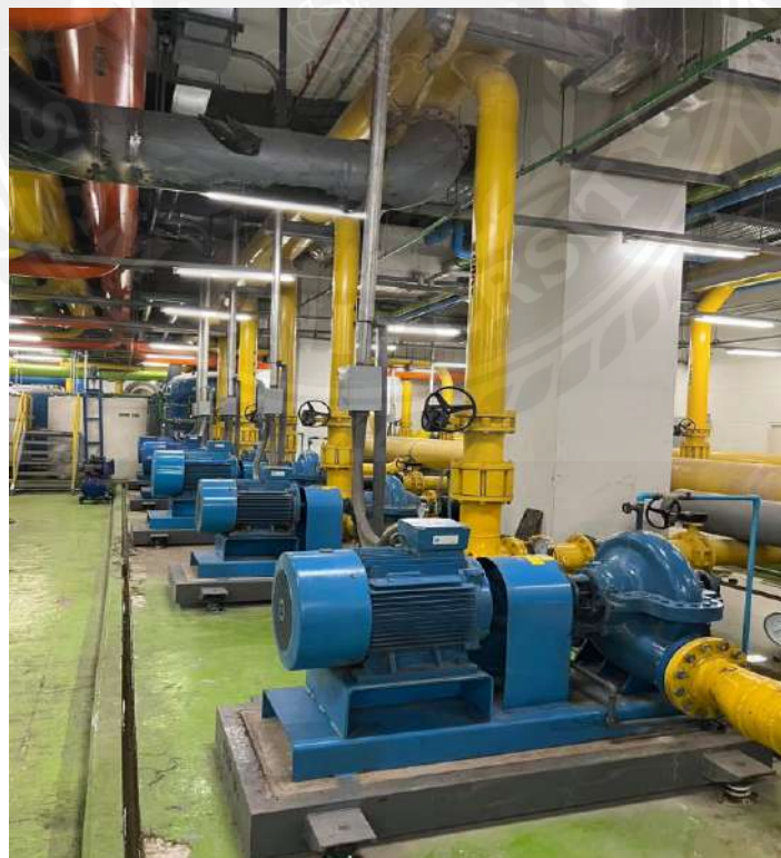
รูปภาพผนวก ที่ 4 บริเวณ Condensate Pump
