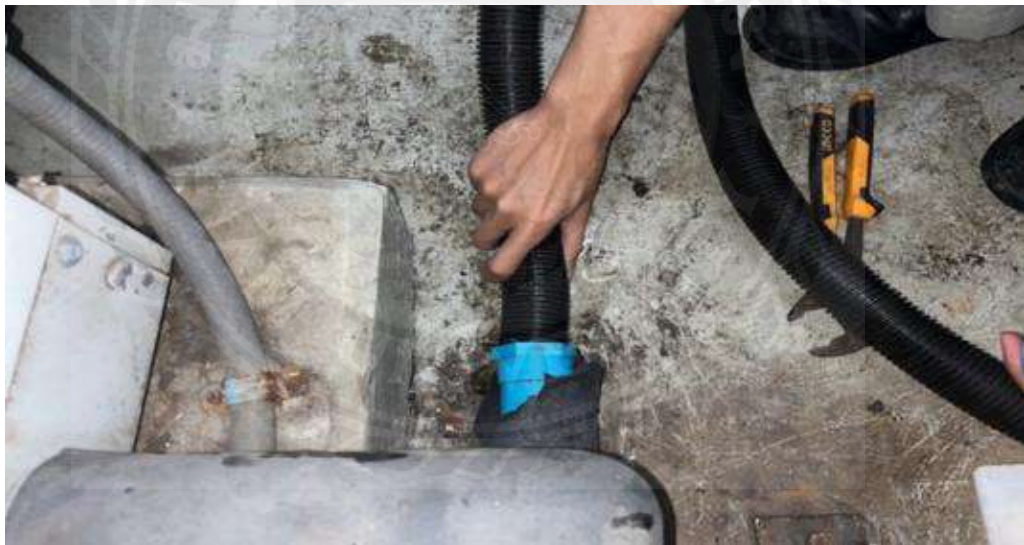
รูปที่ 3.15 ใช้โบลเวอร์ดูด ตะกอนในท่อเตรน
