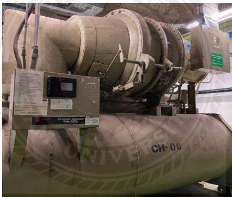
รูปที่ 2.4 A large centrifugal chiller
