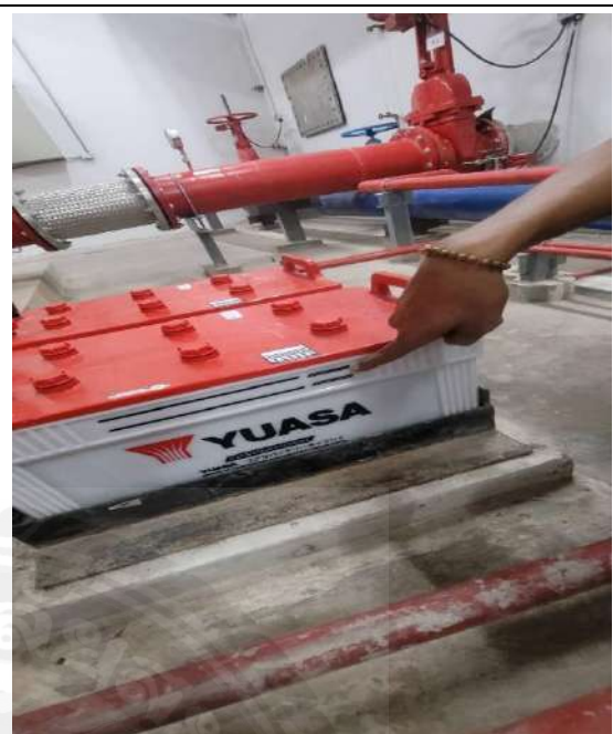
รูปภาคผนวก ที่ 60 ระดับน้ำกลั่นของแบตเตอรี่อยู่ที่ \frac{3}{4}
