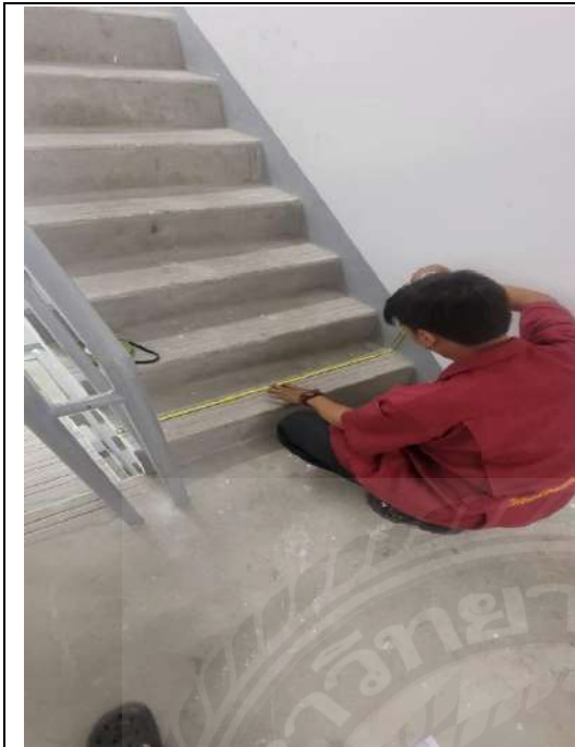
รูปภาคผนวก ที่ 9 วัดความกว้างบันไดที่ 1
