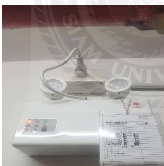
รูปภาคผนวก ที่ 48 ปุ่ม Test ป้ายไฟฉุกเฉิน
