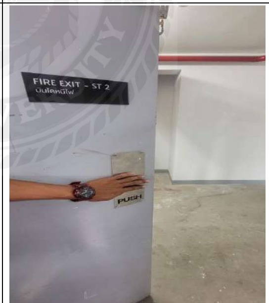
รูปภาคผนวก ท 4 อุปกรณ์เป็นชนิดแบบมือผลัก
