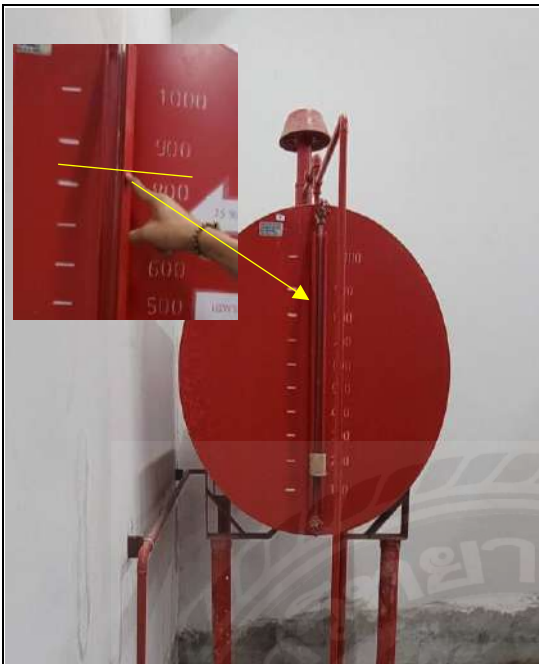
รูปภาคผนวก ที่ 59 ระดับน้ำมันเชื้อเพลิงอยู่ \frac{3}{4} ของถัง ต่ำกว่า เกณฑ์
