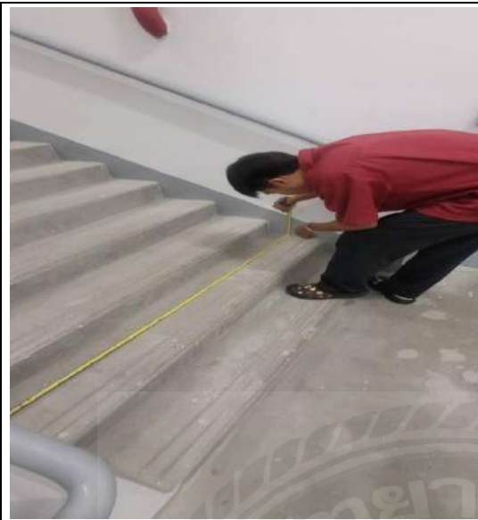
รูปภาคผนวก ที่ 17 วัดความกว้างบันไดที่ 2
