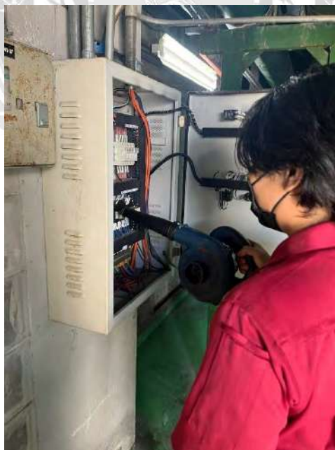
รูปที่ 4.2.2 ทำความสะอาดภายในตู้ควบคุมในส่วนของเทอร์มินอลบล็อก
