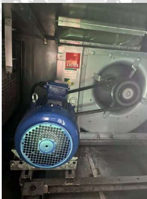
รูปที่ 4.2.5 ดำเนินการตรวจสอบในส่วนของสายพานมอเตอร์
