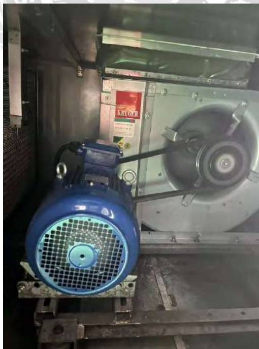
ดำเนินการตรวจสอบในส่วนของสายพานมอเตอร์
