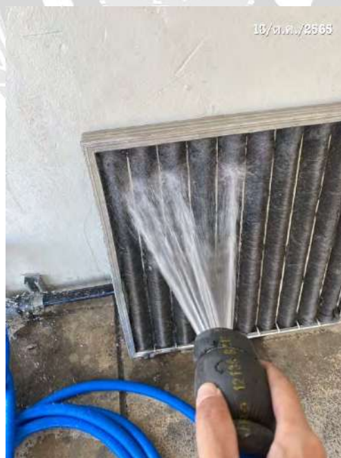
รูปที่ 4.2.7 ทำความสะอาดฟิวเตอร์กรองอากาศ
