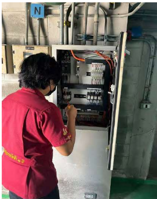
ทำการตรวจสอบตู้ควบคุมระบบปรับอากาศ
