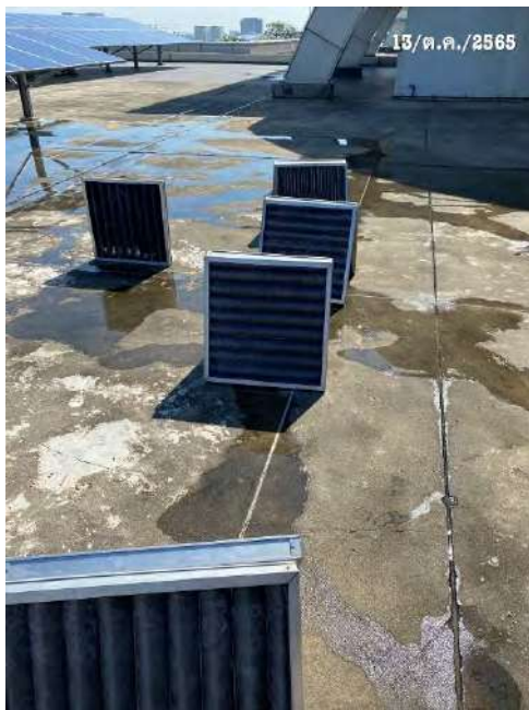
รูปที่ 4.2.8 นำฟิวเตอร์กรองอากาศตากแดดให้แห้ง
