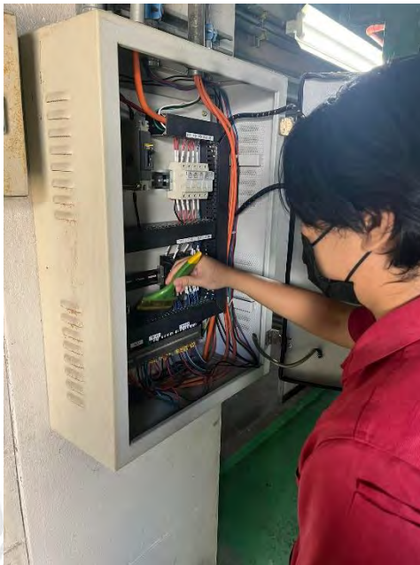
รูปที่ 4.2.2 ทำความสะอาดภายในตู้ควบคุมในส่วนของเทอร์มินอลบล็อก
