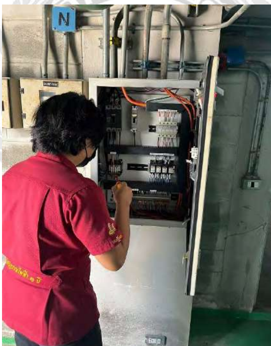
รูปที่ 4.2.1 ทำการตรวจสอบตู้ควบคุมระบบปรับอากาศ
