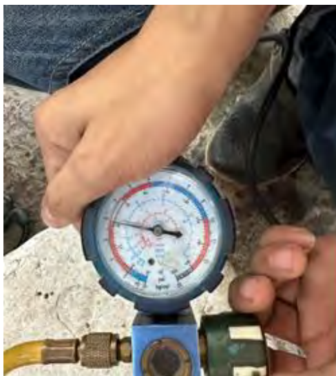
รูปที่ 4.18 การตรวจวัดความดันน้ำยาสารทำความเย็น
