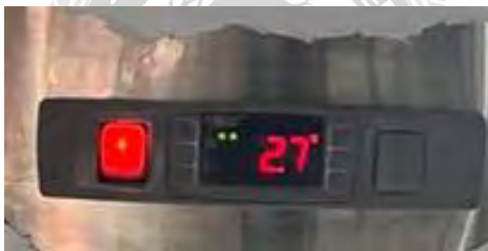
รูปที่ 4.19 การตรวจวัดอุณหภูมิในห้องแช่เย็น
