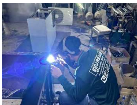
รูปที่ 4.13 การเชื่อมเดินท่อสารทำความเย็น
