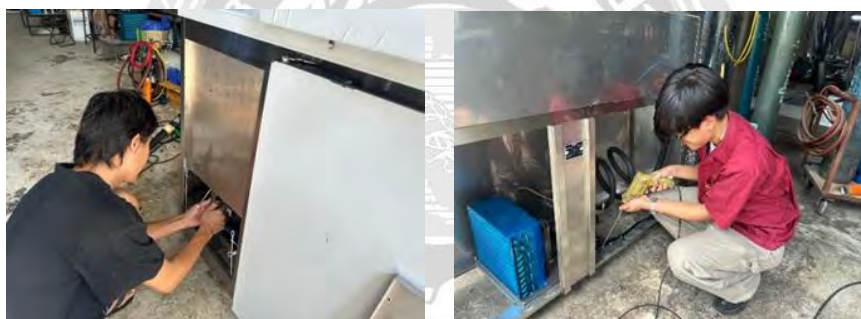
รูปที่ 4.12 การประกอบและติดตั้งชุดคอยล์เย็นและคอมเพรสเซอร์
