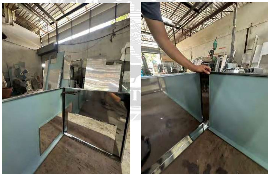
รูปที่ 4.10 การติดตั้งยึดรางของชั้นวางและขอบประตู
