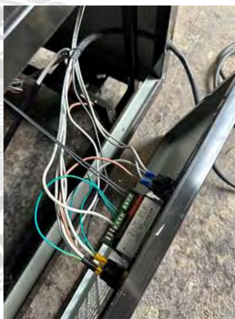
รูปที่ 4.17 การ Wiring วงจรไฟฟ้า และจัดเก็บสายไฟฟ้า
