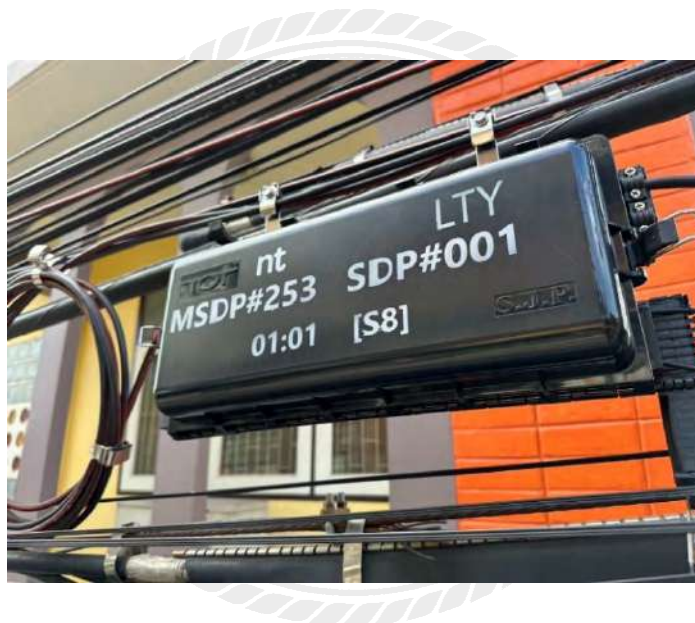
รูปที่ 2.13 ตู้อุปกรณ์ตู้ชุมสาย Internet (SDP)
