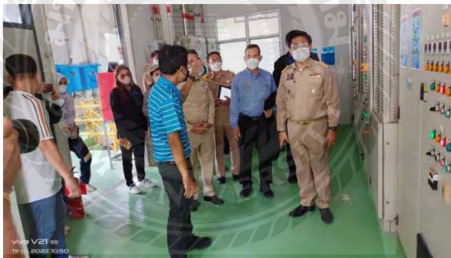
รูปที่ 5.2 อธิบายขั้นตอนการทำงานของตู้ควบคุมมอเตอร์
