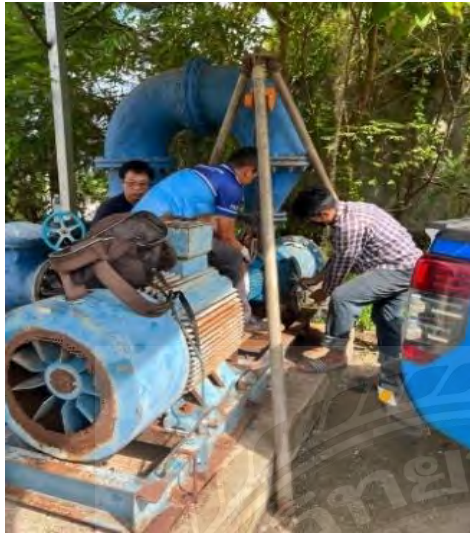
4.8.1 นำมอเตอร์ไปเปลี่ยนลูกปืนเพลาลูกเบี้ยวและใบพัด
