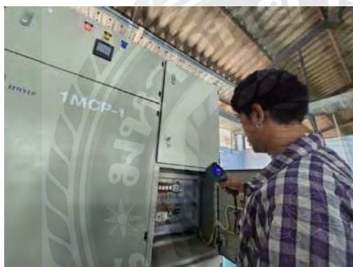
4.4.3 ตรวจเช็คอุณหภูมิตู้ควบคุมมอเตอร์ขณะทำงาน
