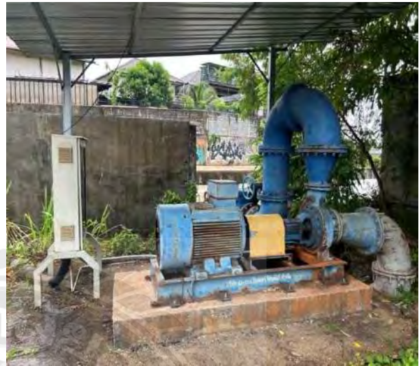
4.8.2 มอเตอร์ที่เปลี่ยนลูกปืนเพลาลูกเบี้ยวและใบพัดเสร็จแล้ว
