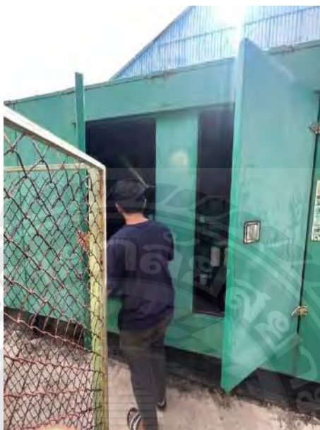
รูปที่ 4.2 เติมน้ำใส่หม้อน้ำ และ เดินระบบแบบ No Load
