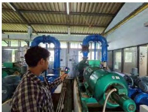
4.4.1 ตรวจเช็คอุณหภูมิมอเตอร์ขณะทำงาน
