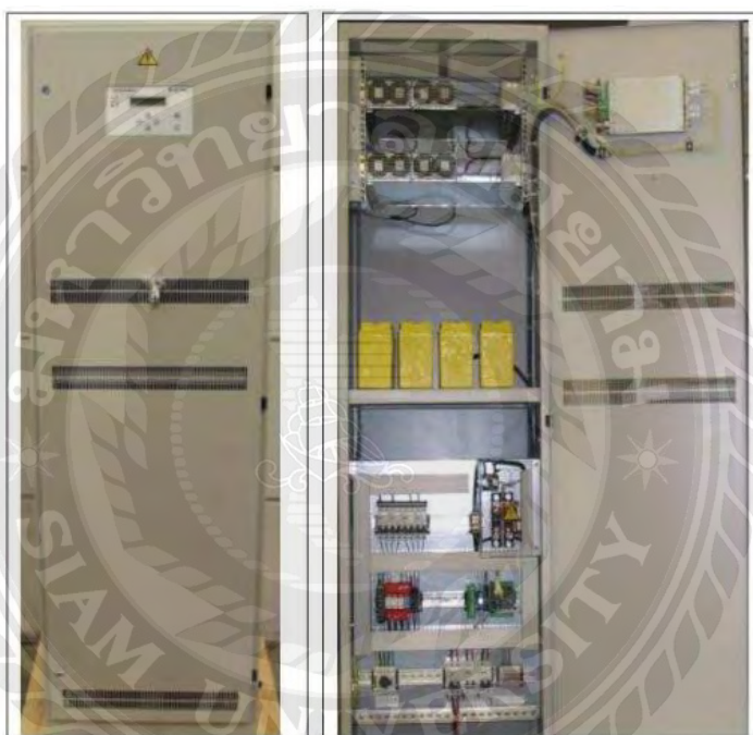
รูปที่ 2.22 แหล่งจ่ายไฟ – กล่องอุปกรณ์เรียงกระแสไฟฟ้า
