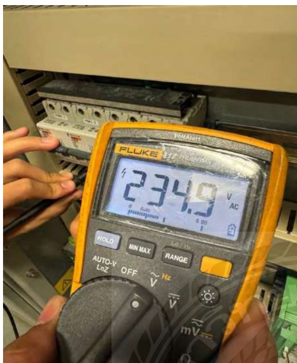
รูปที่ 4.9 วัดกระแสไฟของประตูด PSD และ EED หลังการทำความสะอาดและซ่อมบำรุง
