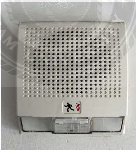
รูปที่ 4.17 อุปกรณ์แจ้งสัญญาณด้วยแสงและเสียง
