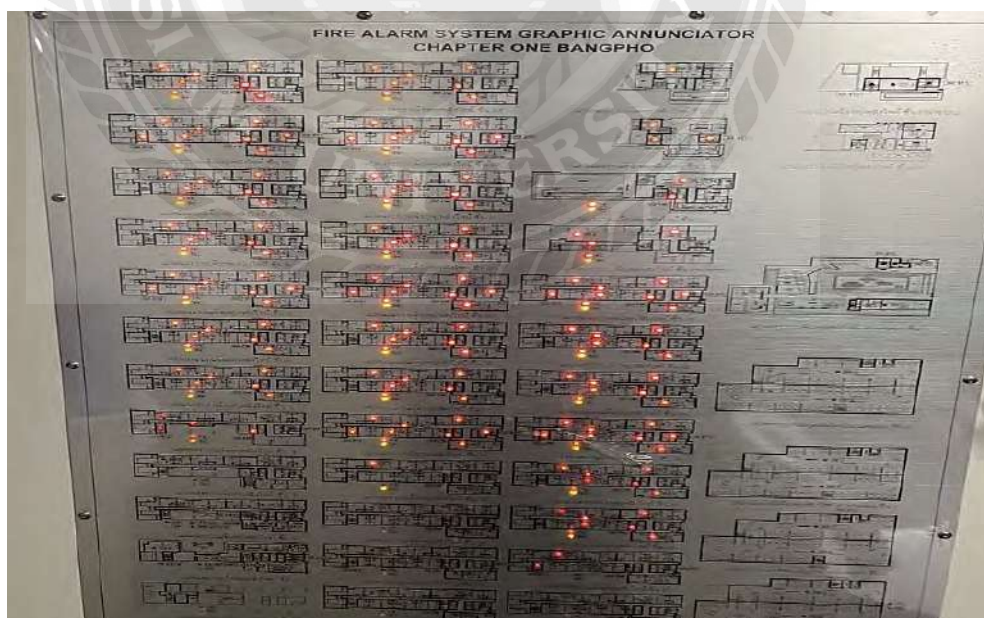
รูปที่ 4.9 Test Lamp Graphic Annunciator
