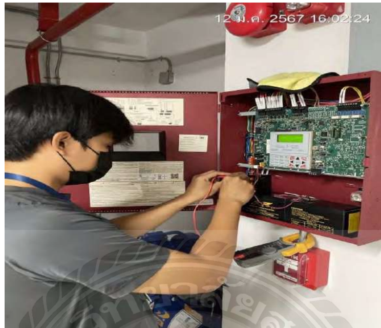
รูปที่ 3 ตรวจสอบเช็คแบตเตอรี่ FM200 ให้อยู่สถานะปกติ
