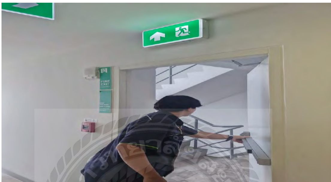
รูปที่ 4.6 ประตุนีไฟเมื่อเกิดเหตุฉุกเฉินจะมีตามชั้นของเจ้าของร่วม
