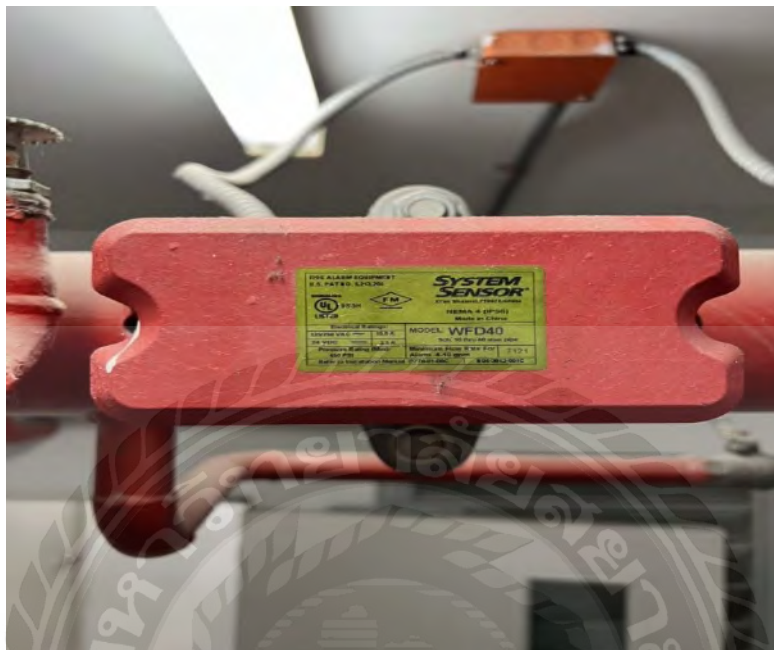
รูปที่ 4.18 อุปกรณ์ตรวจสอบน้ำไหล ( Water Flow switch )
