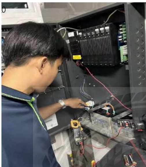
รูปที่ 4.10 วัดแรงดันของ ชุดสำรองไฟฟ้า (Battery Unit) ประจำเดือน
