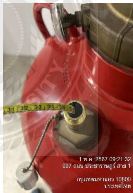
รูปที่ 4.23 ตรวจสอบ FM-200 หรือสารสะอาดในห้องไฟฟ้า MDB ประจำเดือน
