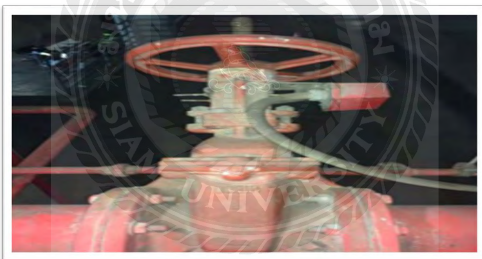
รูปที่ 2.24 อุปกรณ์ตรวจสอบน้ำไหล ( Water Flow switch )
