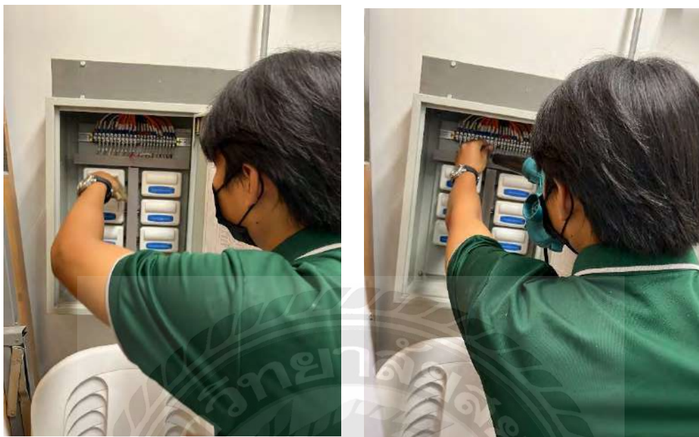
รูปที่ 4.16 อุปกรณ์ระบุตำแหน่ง ( Addressable Modules ) เป็นหน่วยรับ-ส่งสัญญาณ Digital เป้าทำความสะอาด ชุดอุปกรณ์ Signal จาก Detector หรือ Switch แล้วแปลงเป็นเป็น Multiplex Signal ส่งไป ตู้ควบคุม Fire Alarm Control panel
