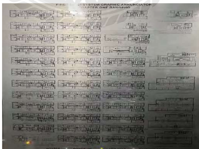
รูปที่ 2.3 Graphic Annunciator
