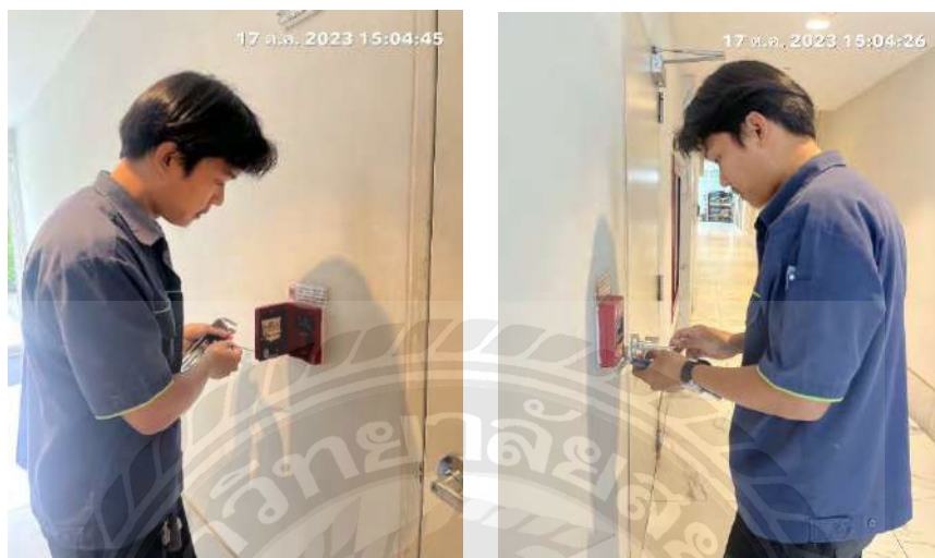
รูปที่ 4.12 Manual Push Station
