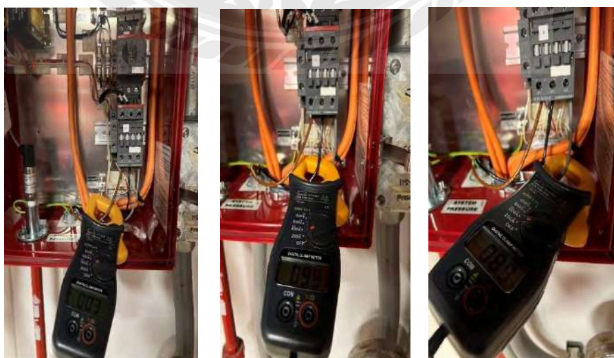
รูปที่ 4.25 ตรวจสอบวัดกระแส Jokey Pump
