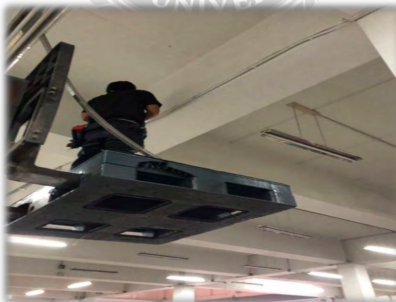
รูปที่ 4.2 การสำรวจระบบไฟฟ้าแสงสว่างที่ต้องการปรับเปลี่ยนระบบการควบคุมเป็น IoT
