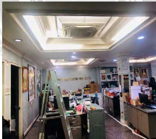
รูปที่ 2 การติดตั้งระบบควบคุมแสงสว่าง
