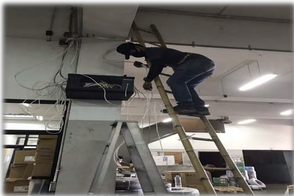
รูปที่ 4.3 การสำรวจระบบไฟฟ้าแสงสว่างที่ต้องการปรับเปลี่ยนระบบการควบคุมเป็น IoT
