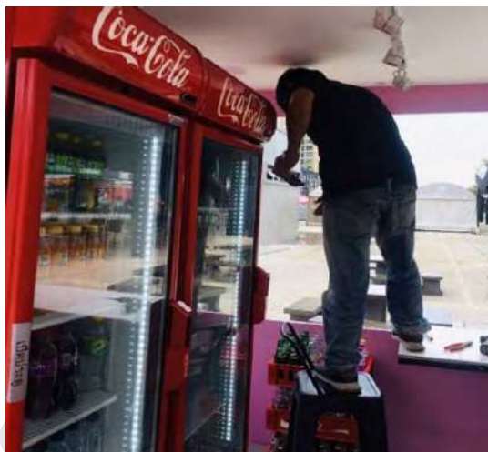
รูปที่ 4.3 ตัวอย่างการติดตั้งกล้องบริเวณจุดจำหน่ายสินค้า
