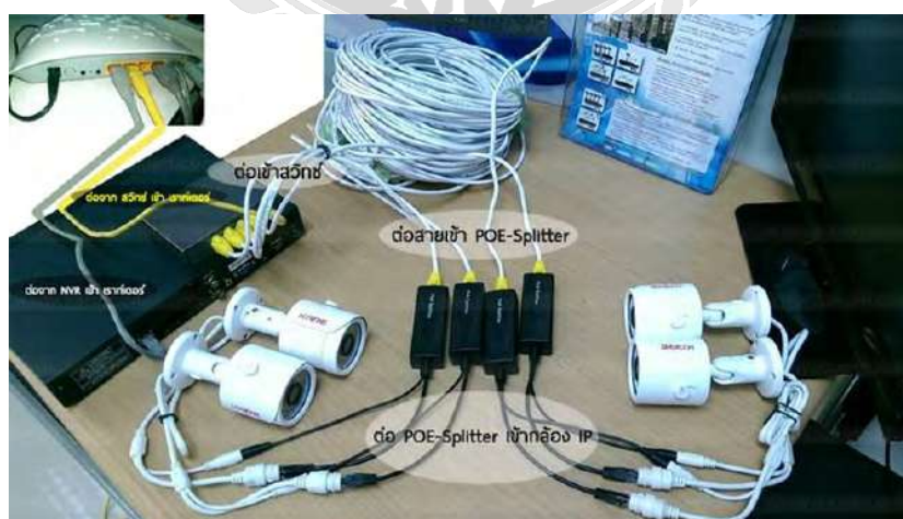
รูปที่ 4.1 ตัวอย่างวัสดุและอุปกรณ์ที่ใช้ในการติดตั้งกล้อง CCTV
