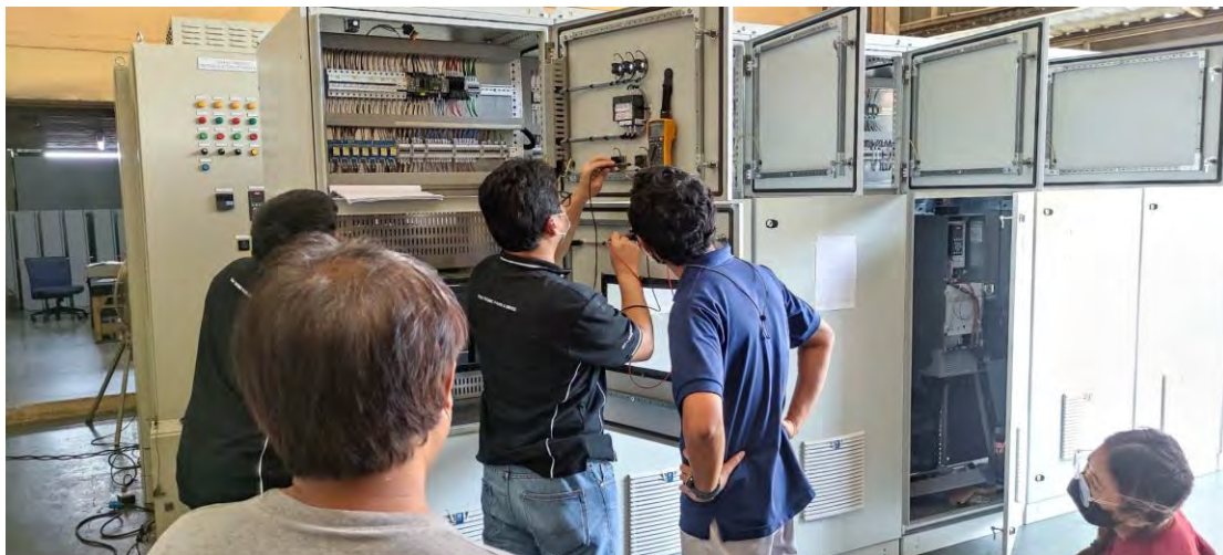
รูปที่ 6 ตรวจสอบอุปกรณ์ในตู้ว่าอุปกรณ์ชนิดใดมีความเสียหายหรือไม่หรือการไวรั้งสายผิดพลาด อย่างไร
