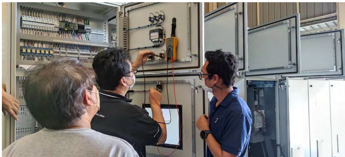
รูปที่ 4.29 ทำการตรวจสอบการไวรั้งสายของตัวอุปกรณ์
