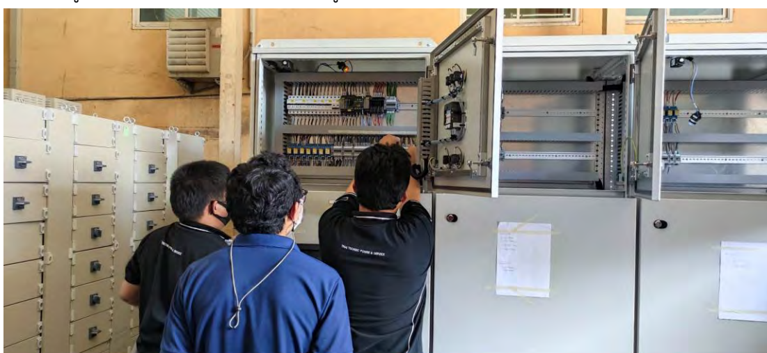
รูปที่ 4.27 ทำการทดสอบระบบวงจรของสวิตช์บอร์ด
