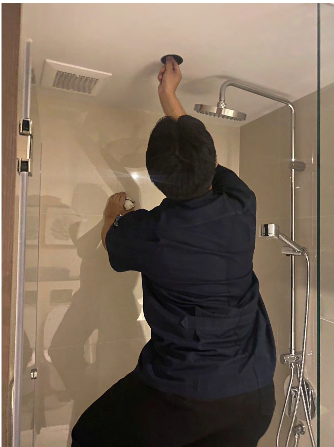
รูปที่ 4.7 ทำการเปลี่ยนหลอดไฟในห้อง Shower ในห้องพักแขก
