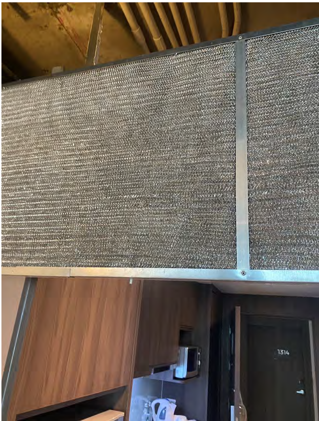
รูปที่ 4.11 ทำการถอดฟیلเตอร์แอร์ในห้องพักแขก
