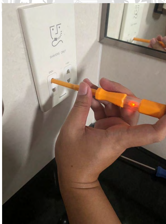
รูปที่ 4.10 ทำการใช้ไขควงวัดไฟฟ้าเช็คไฟเข้า
