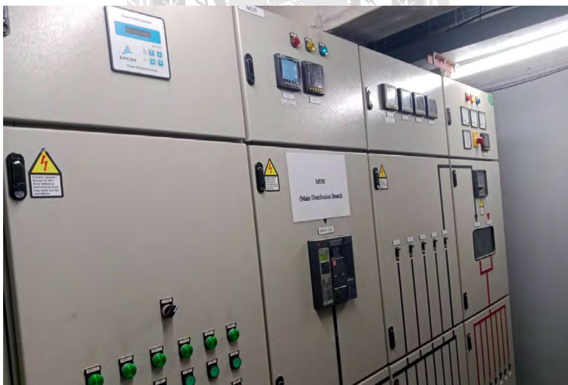
รูปที่ 4.21 การตรวจเช็คการทำงานของตู้ MDB ของตึก 2
