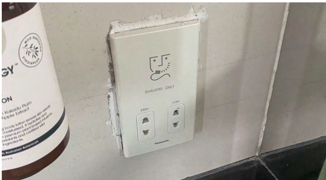
รูปที่ 4.9 ทำการติดตั้งปลั๊กโกนหนวดในห้องพักแวก
