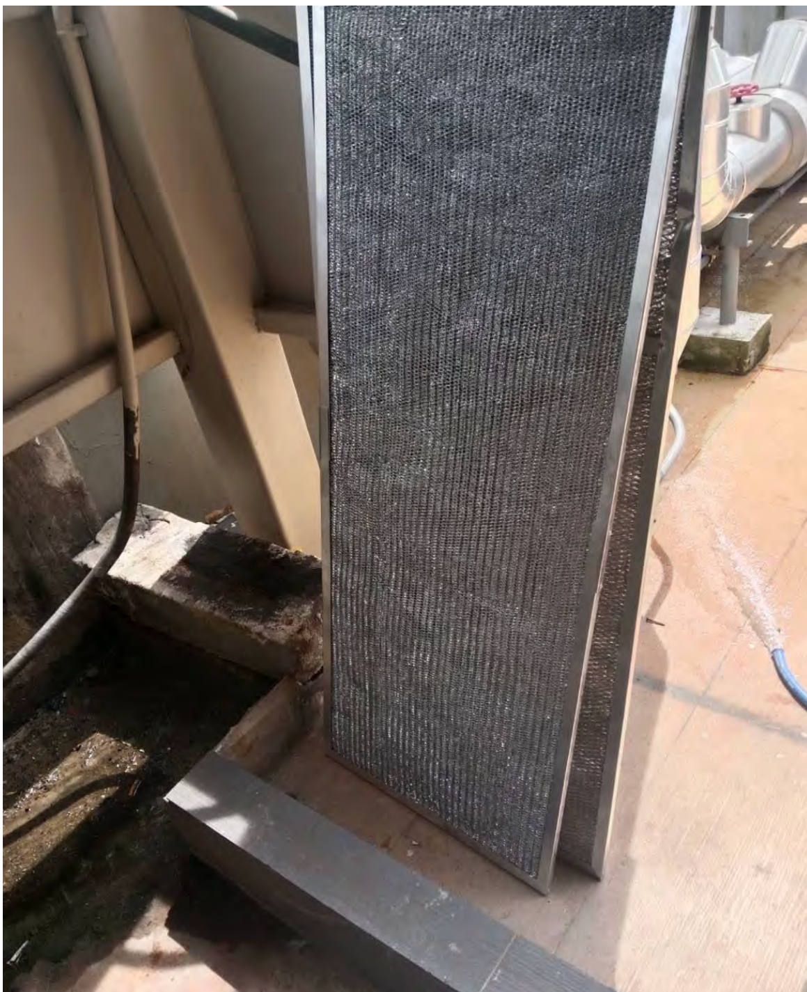
รูปที่ 4.12 ทำการล้างฟิลเตอร์แอร์
