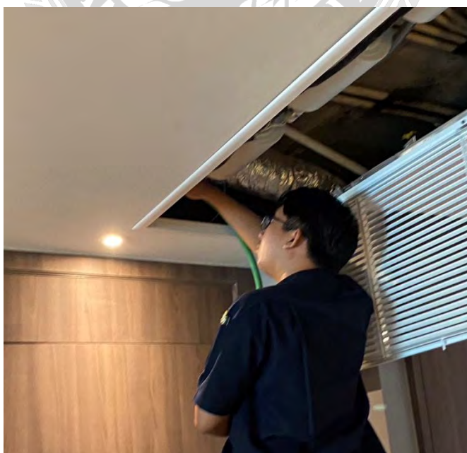
รูปที่ 4.6 ทำการดูน้ำจากถาดน้ำแอร์ ในห้องพักแขก
