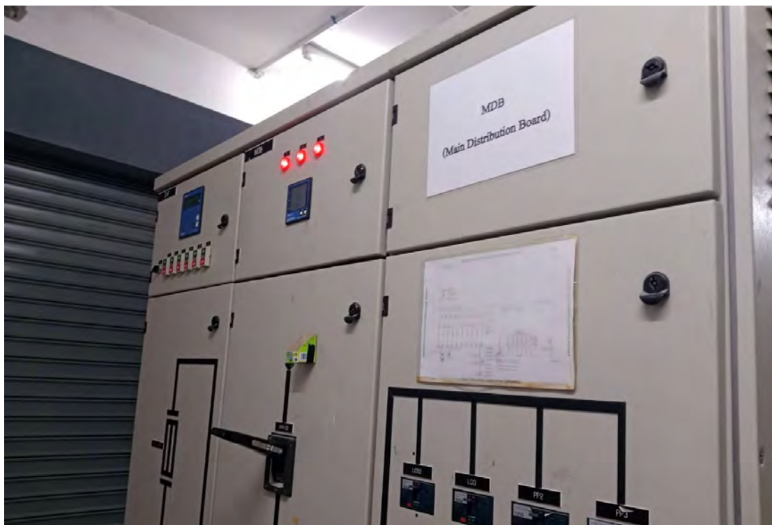
รูปที่ 4.20 การตรวจเช็คการทำงานของตู้ MDB ของตึก 1
