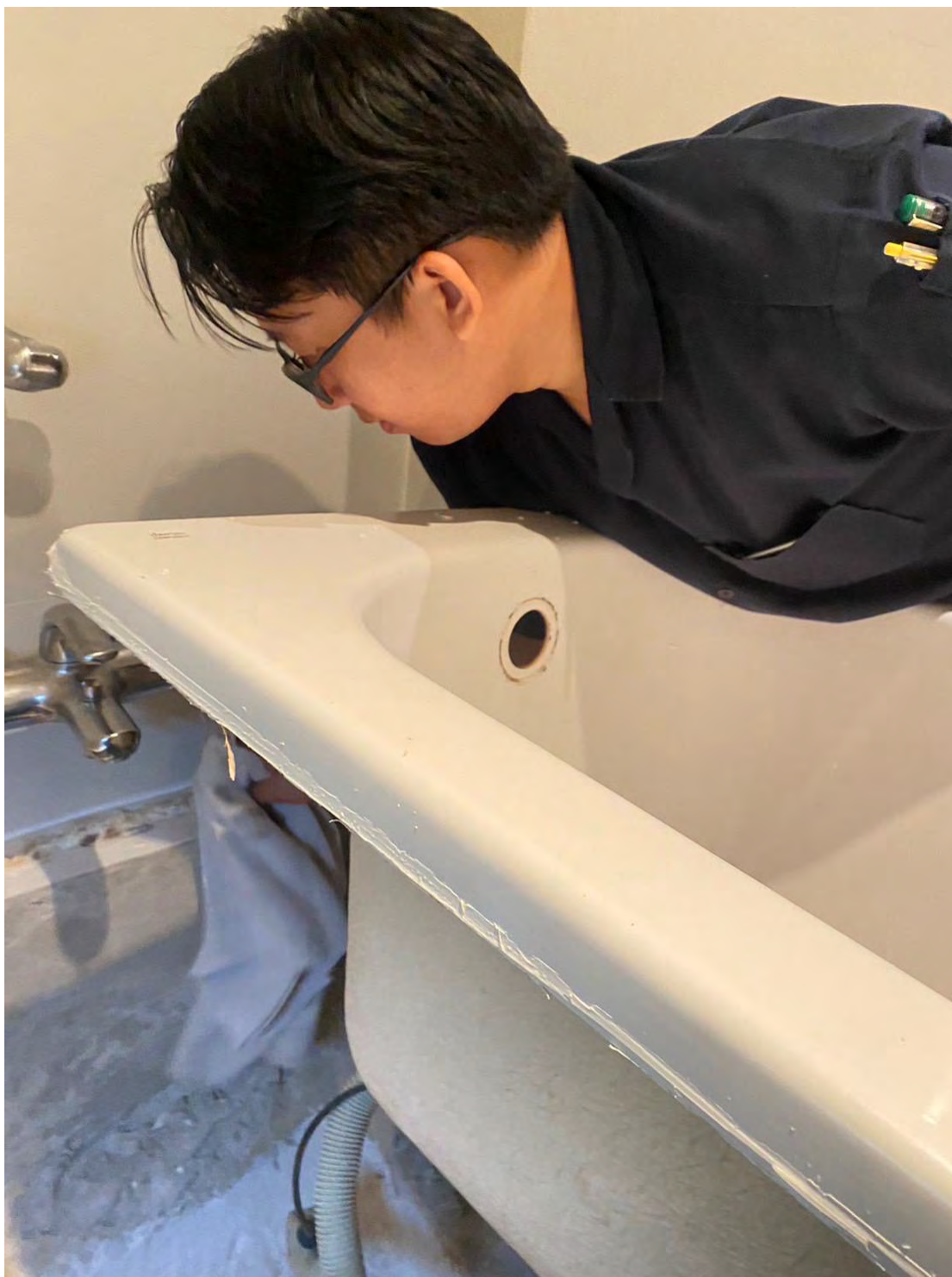
รูปที่ 4.8 ทำการยกอ่างอาบน้ำห้องแขก
