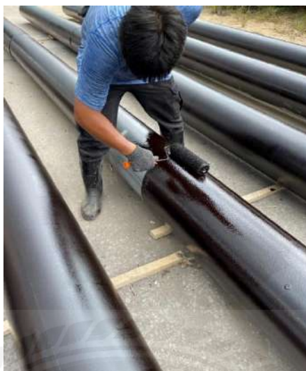
รูปภาคผนวกที่ 11 ทาสีโคลทาร์อีพ็อกซี่ ( สีน้ำตาล ) ชั้นที่ 2 ทั้งเส้น
