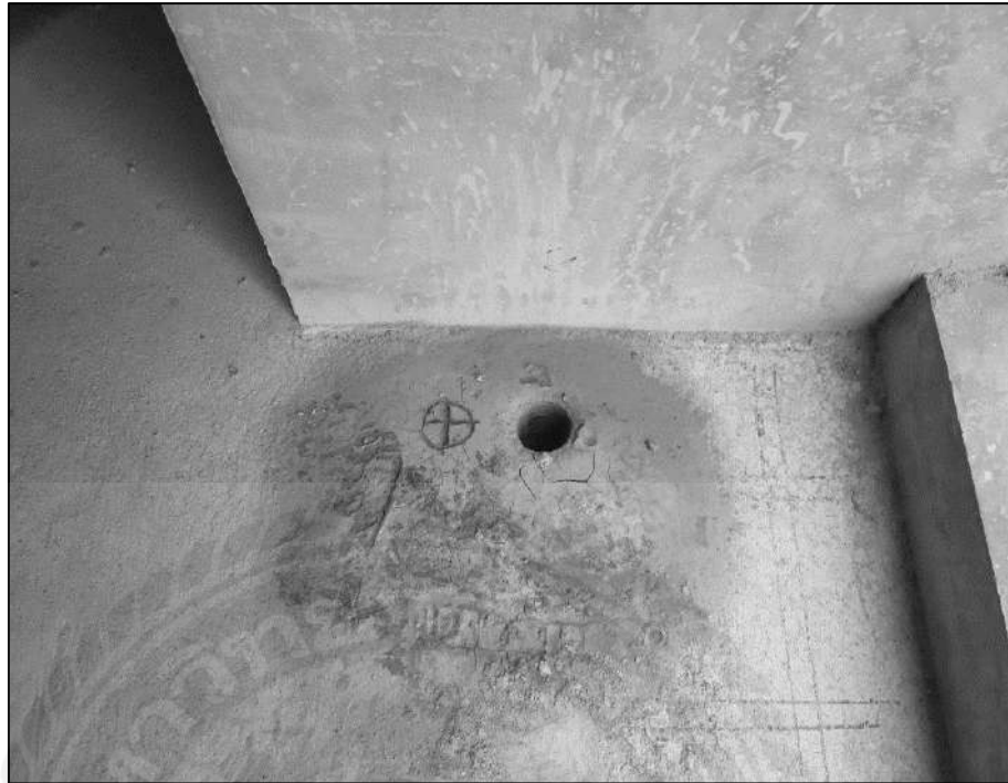
รูปที่ 4.9 เจาะคอนกรีตด้วยเครื่องเจาะพื้นเพชร
