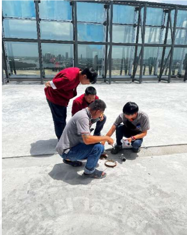
รูปที่ ก.3 นักศึกษาและวิศวกรพี่เลี้ยงทำการตรวจสอบงานบริเวณชั้นดาดฟ้า
