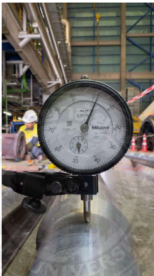
รูปที่ 4.5 ค่าที่ได้ + 0.02 ไม่เกินค่าที่กำหนด
