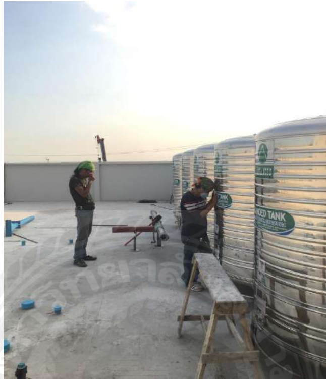
รูปที่ ข.5 การติดตั้งถังเก็บน้ำแบบสแตนเลส
