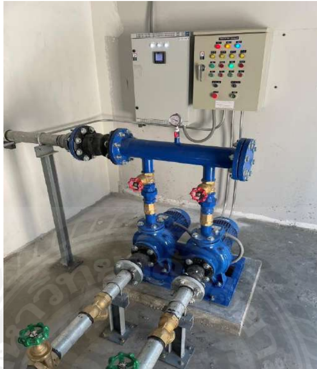
รูปที่ ข.7 การติดตั้งปั๊มส่งน้ำประปา (Transfer Pump) เข้าถึงเก็บน้ำสแตนเลสบนตาดฟ้า
