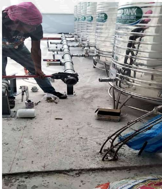
รูปที่ ข.6 การเดินท่อส่งน้ำประปาหลัก (Main Riser)
