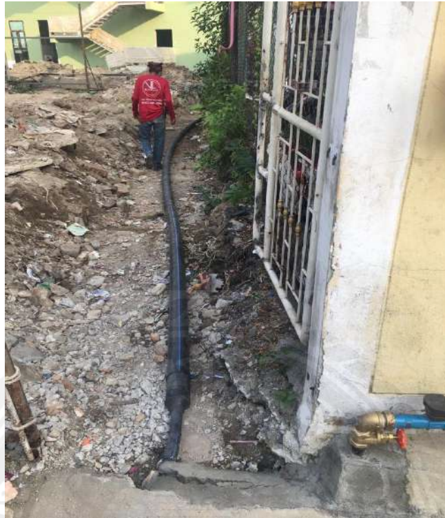
รูปที่ ข.3 การเดินท่อรับน้ำจากมิเตอร์ของการประปาเข้าบ่อสำรองน้ำ
