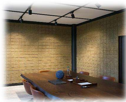
รูปภาพที่ 3.11 ผนังดูดซับเสียงจากฟางข้าวและกะลาตากาแฟ (Eco Acoustic Mosaic)
