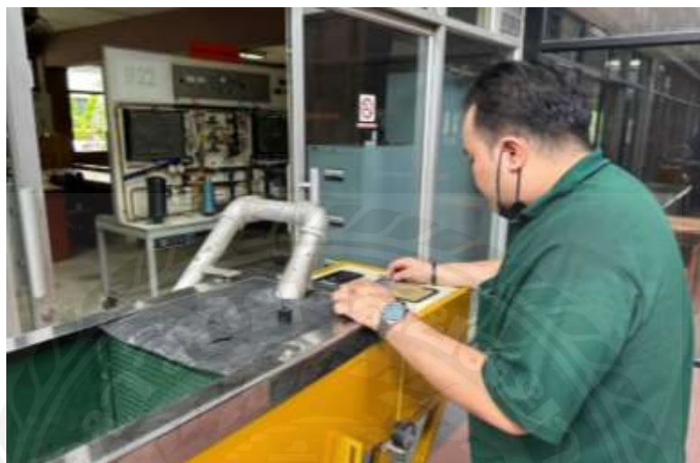
รูปที่ 3.26 ตรวจสอบ Inverter
