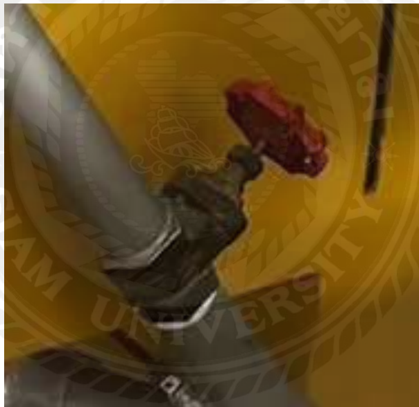
รูปที่ 3.9 วาล์วปรับแรงดัน (Gate Valve)
