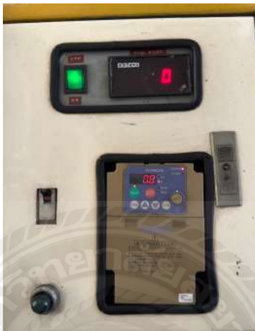
รูปที่ 3.43 หมายเลข 3 Inverter
