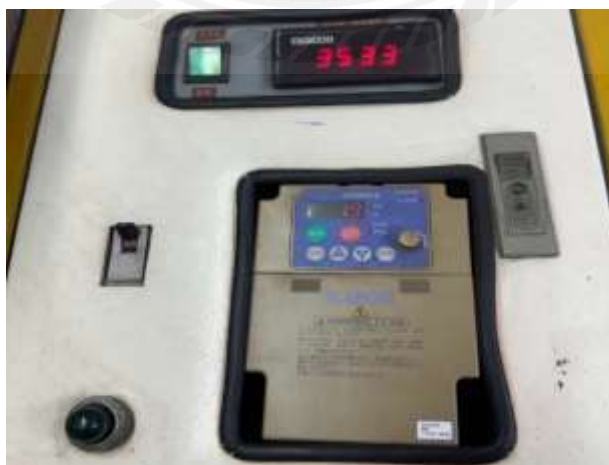
รูปที่ 3.16 ชุดควบคุมความเร็วของปั๊ม
