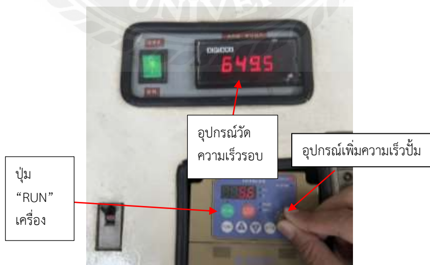
รูปที่ 3.36 การปรับความเร็วรอบของปั๊ม
