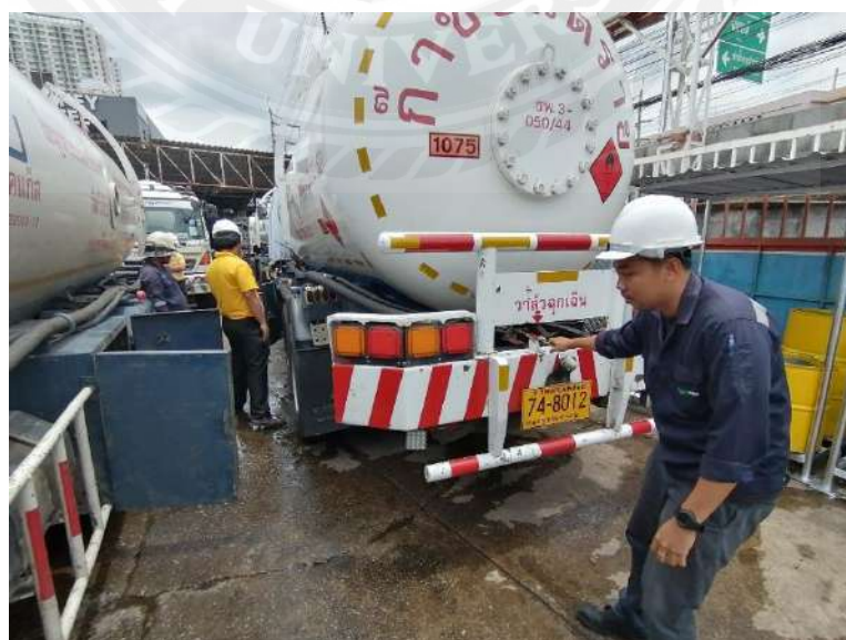
รูปที่ 3.5 การทดสอบการทำงาน Emergency shut-off valve
