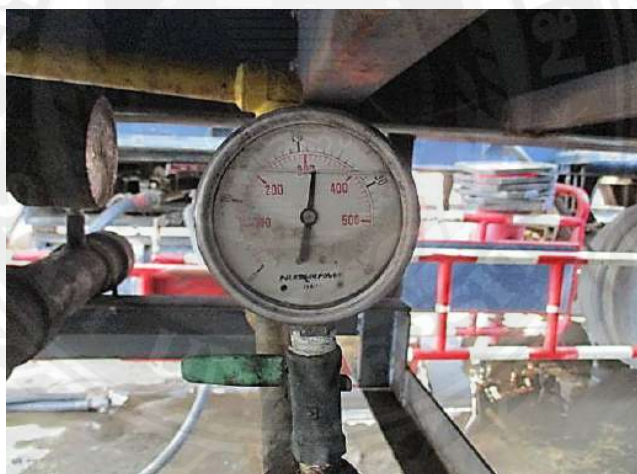
รูปที่ 5.1 Pressure gauge หลังจากอัดแรงดันน้ำ
