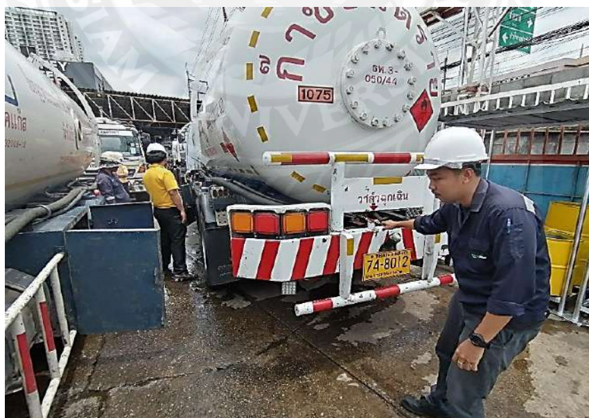
รูปที่ 5.3 การทดสอบการทำงาน Emergency shut-off valve
