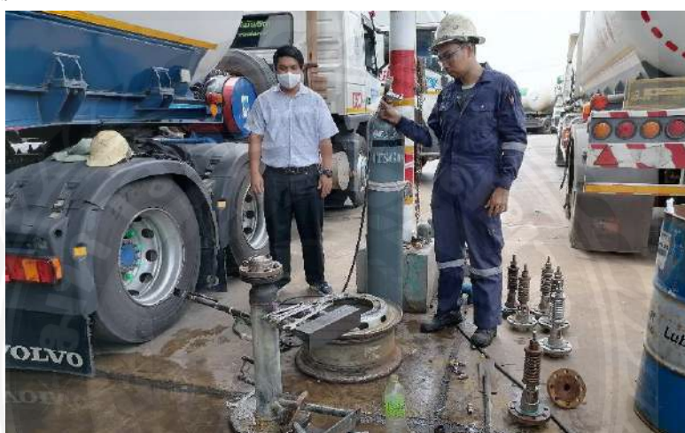
รูปที่ 3.6 การทดสอบการทำงาน Internal safety relief valve
