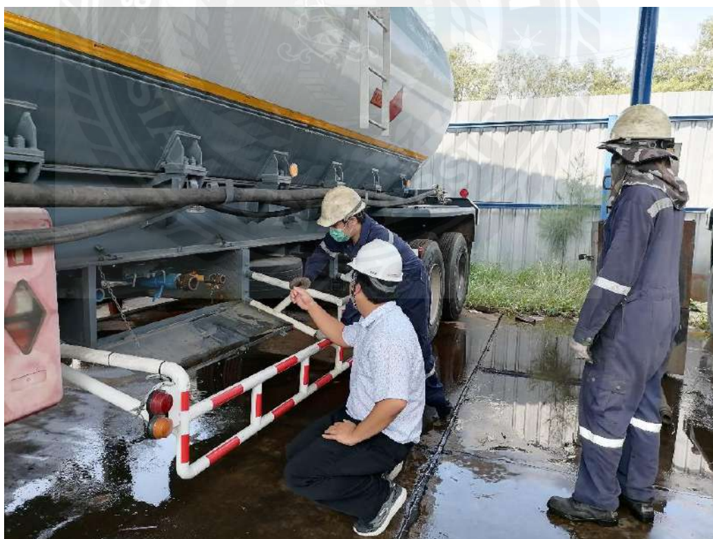
รูปที่ 3.3 การตรวจสอบการติดตั้ง อุปกรณ์ติดตั้งประจำถังก๊าซและระบบท่อ
