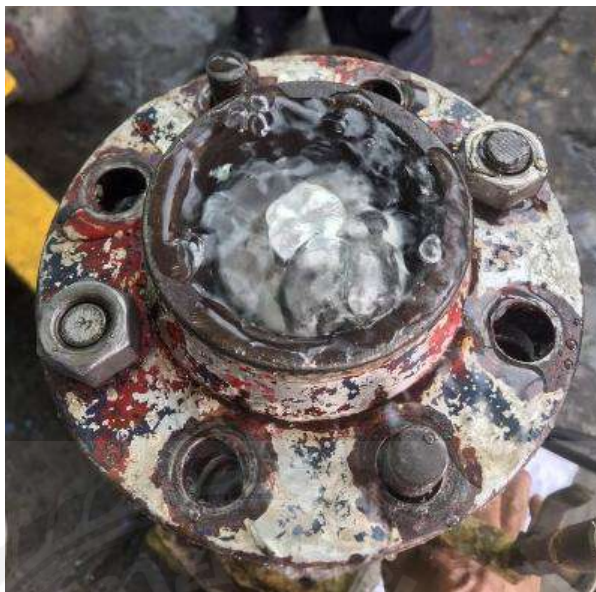
รูปที่ 5.8 Hydro static relief valve เปิด
