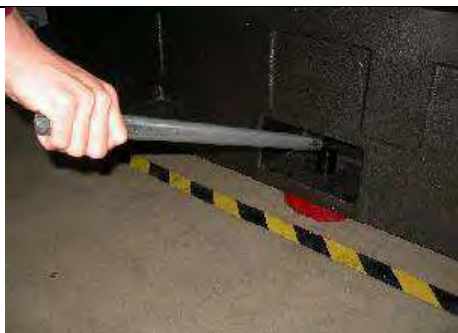
รูปที่ 4.22 การขันปรับตำแหน่งของแผ่นรอง สลักเกลียว
