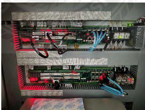
รูปที่ 2.5 บอร์ดควบคุมระบบCNC
