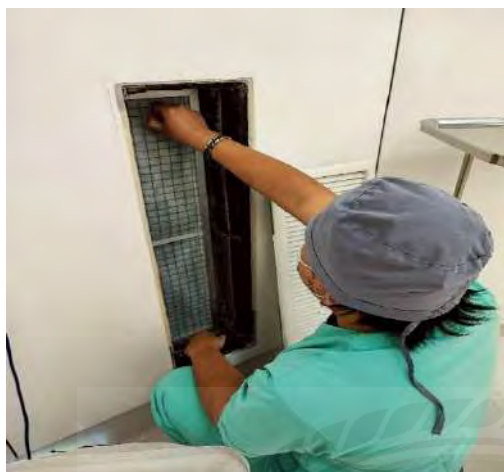
รูปภาคผนวก ที่ 1 ถอดเช็คฟیلเตอร์ ภายในห้อง
