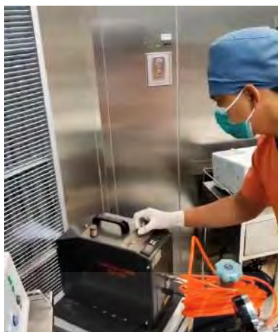
รูปภาคผนวก ที่ 5 ทดสอบปล่อยควันเพื่อเช็คอัตราการไหลของ อากาศ
