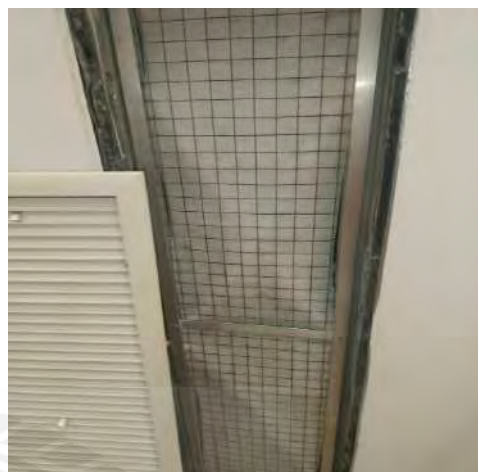
รูปภาคผนวก ที่ 2 หลังจากเปลี่ยนเสร็จเรียบร้อยแล้ว
