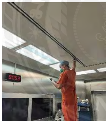
รูปภาคผนวก ที่ 7 ตรวจเช็ครอยรั่วของ Medium ภายในห้อง
