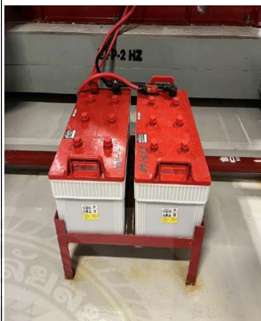
รูปภาคผนวก ที่ 10 แบตเตอรี่ 12V 200Ah
