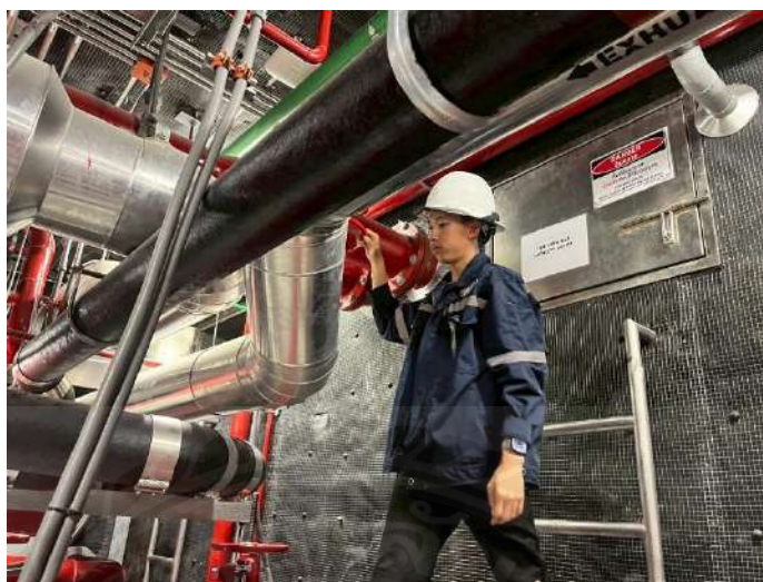
รูปที่ 3.10.11 ปิด และ เปิดวาล์วตามป้ายที่ติดไว้
