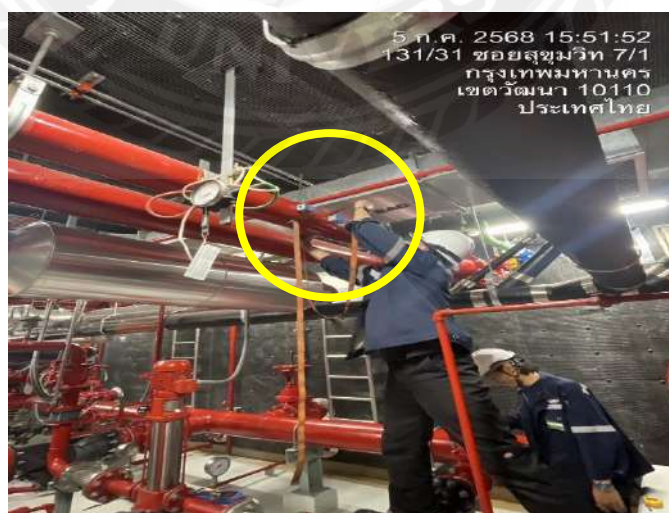
รูปที่ 3.10.1 หาตำแหน่งที่ติดตั้งเครื่อง Flow Meter
