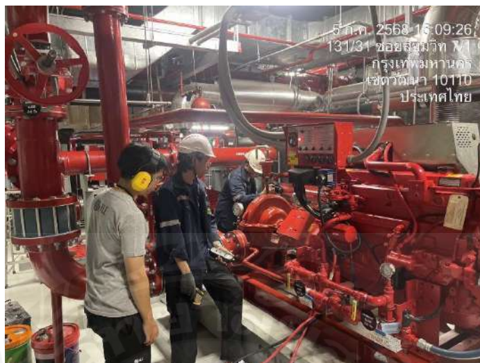
รูปที่ 3.10.9 บันทึกการทำงานของตู้ควบคุมการทำงาน
