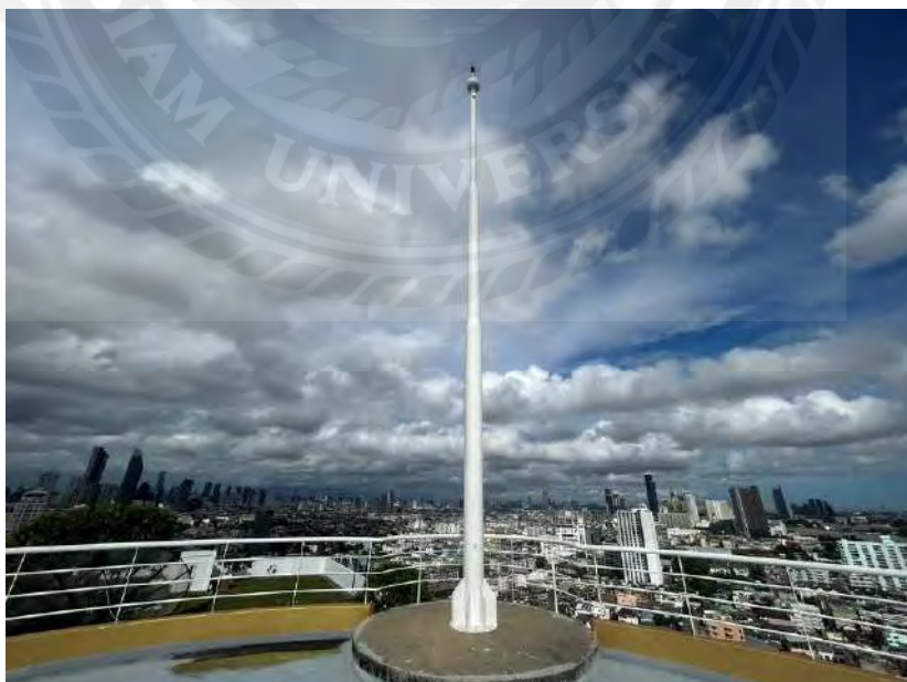
รูปที่ 3.35 การตรวจสอบระบบตัวนำสายล่อฟ้า
