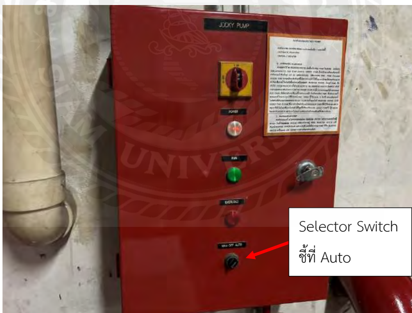
รูปที่ 3.26 ตู้ควบคุมเครื่องสูบน้ำดับเพลิง
