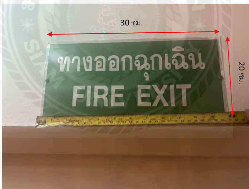
รูปที่ 3.17 ขนาดป้ายบอกทางหนีไฟความกว้าง 20 ซม. และ ยาว 30 ซม.
