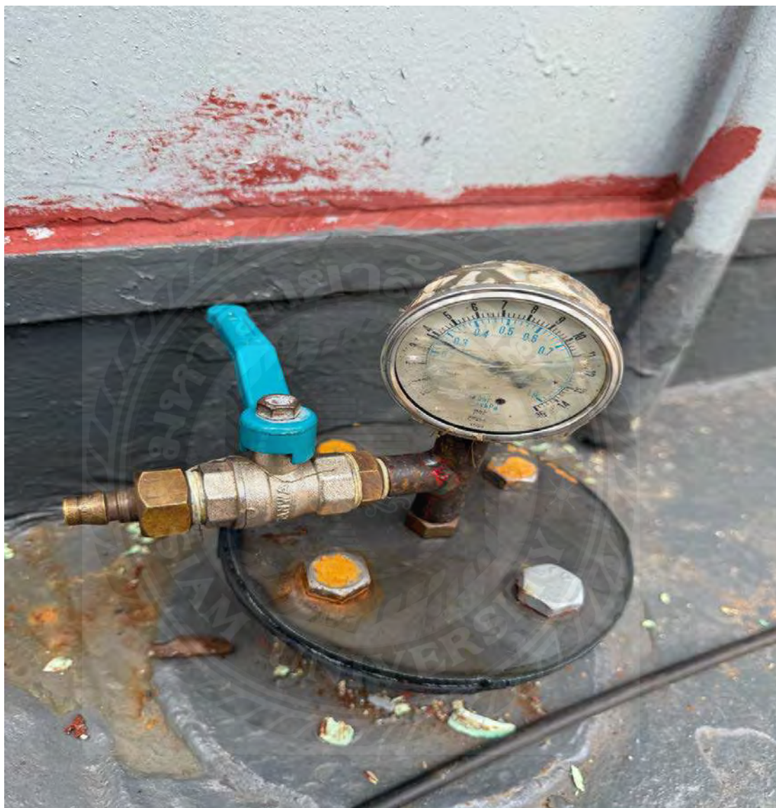
รูปที่ 3.21 เมื่อปล่อยลมเข้าถึงจนได้แรงดันตามกำหนดให้ปิดเกจทิ้งไว้
