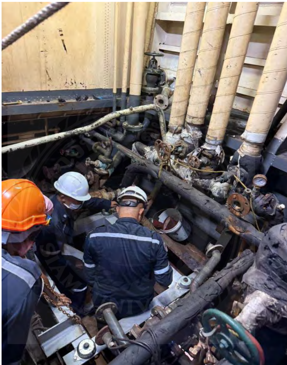
รูปที่ 3.5 การเตรียมชิ้นงานก่อนการเชื่อม
