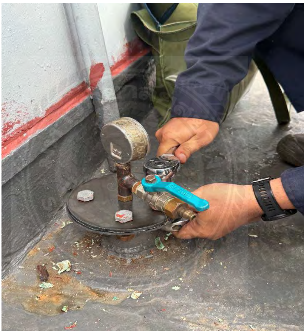
รูปที่ 3.18 ปิดหน้าแปลนและวาล์วต่าง ๆ ทุกจุดที่เชื่อมต่อกับถังน้ำมันให้สนิท
