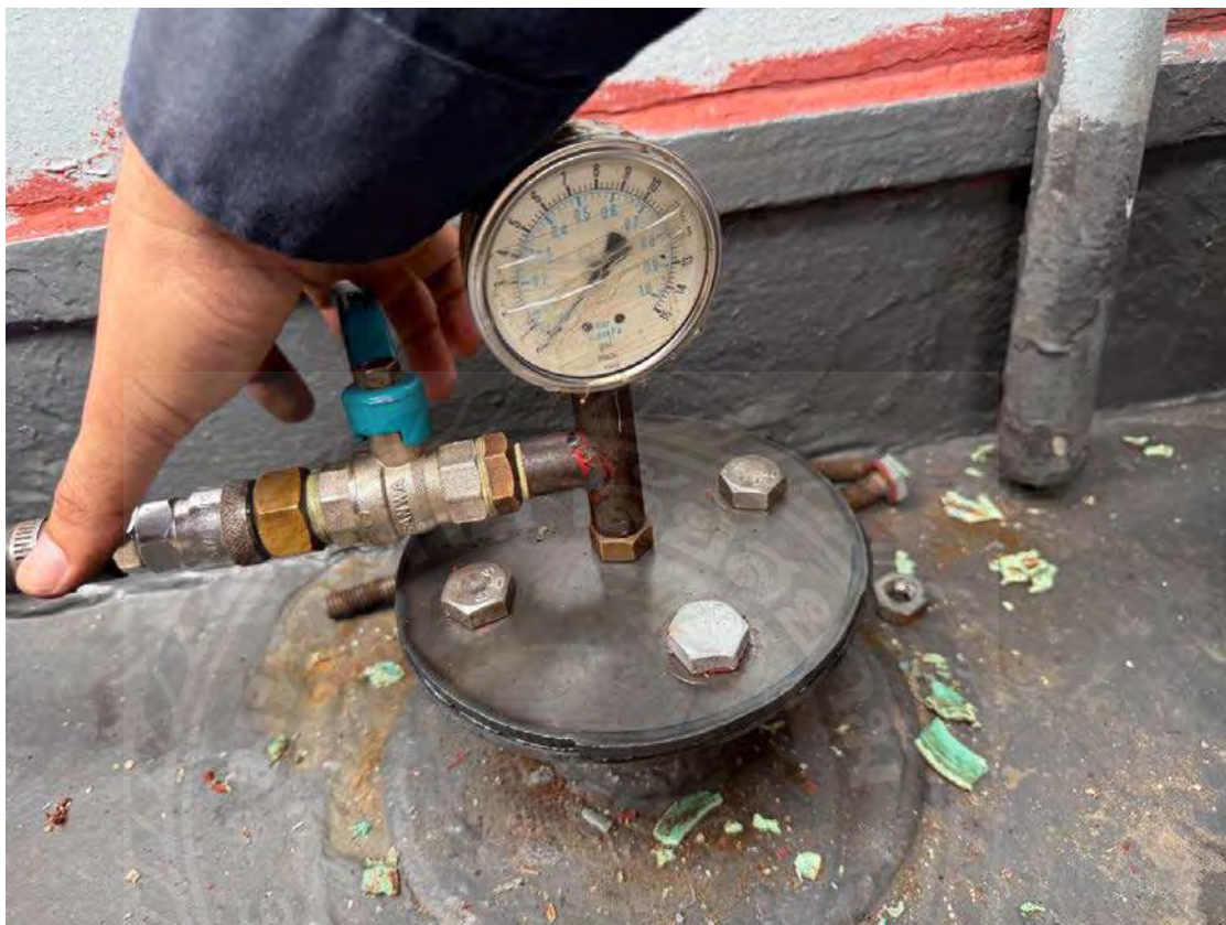
รูปที่ 3.19 ต่อเกจวัดความดันเข้ากับปั๊มลมและรูเติมน้ำมันให้แน่นหนา
