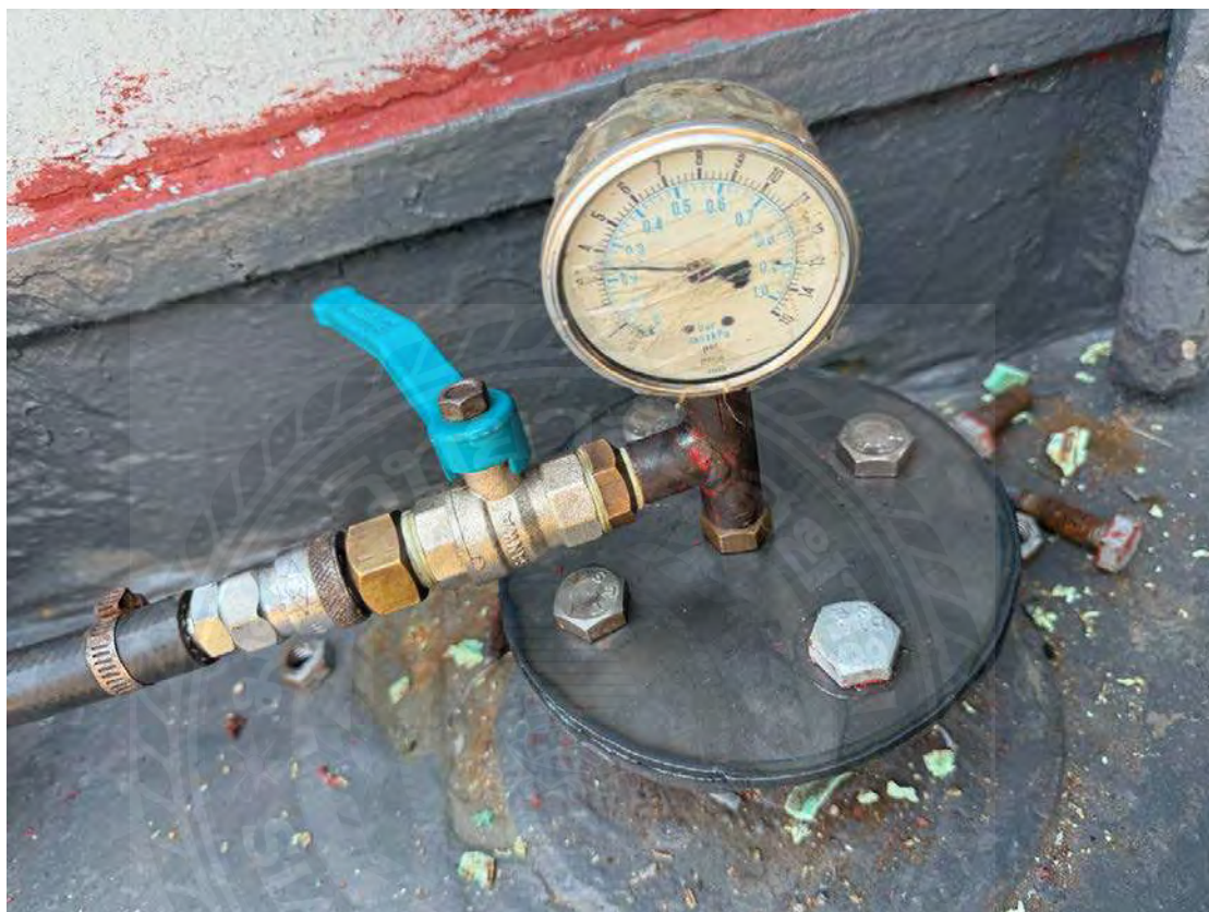
รูปที่ 3.20 ป้อนลมเข้าไปในถัง ประมาณ 0.2 - 0.3 bar. และห้ามใช้แรงดันที่สูงเกินไป
