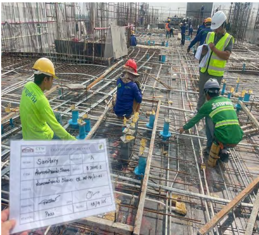
รูปที่ 3.8 ติดตั้งวางรูสลีฟ
