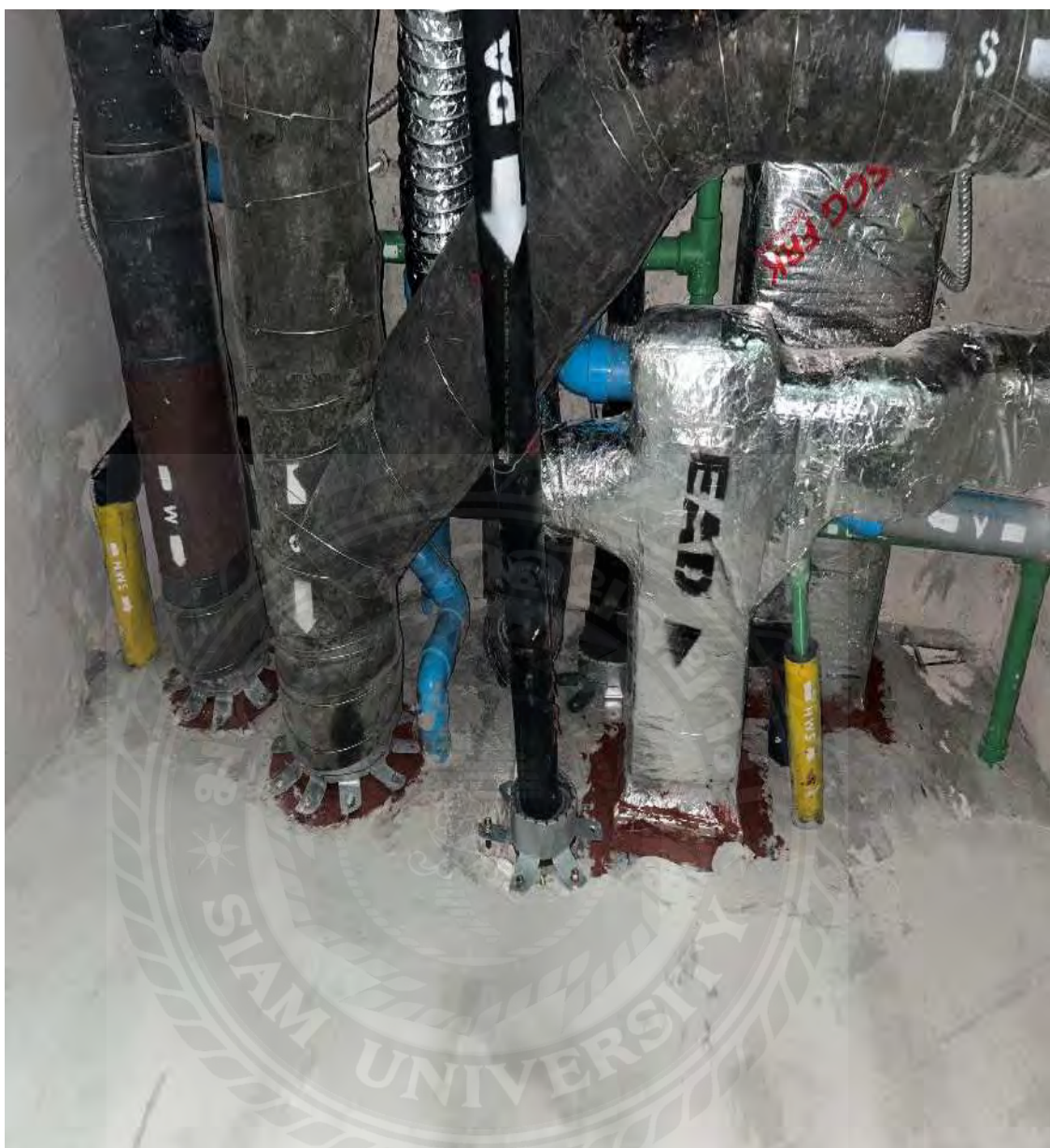
รูปที่ 3.22 ฉนวนที่หุ้มท่อเพื่อป้องกันเสียงและการสั่นสะเทือน
