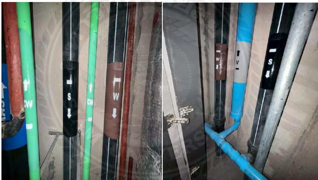
รูปที่ 3.29 สีและสัญลักษณ์ของท่อน้ำสุขาภิบาล
