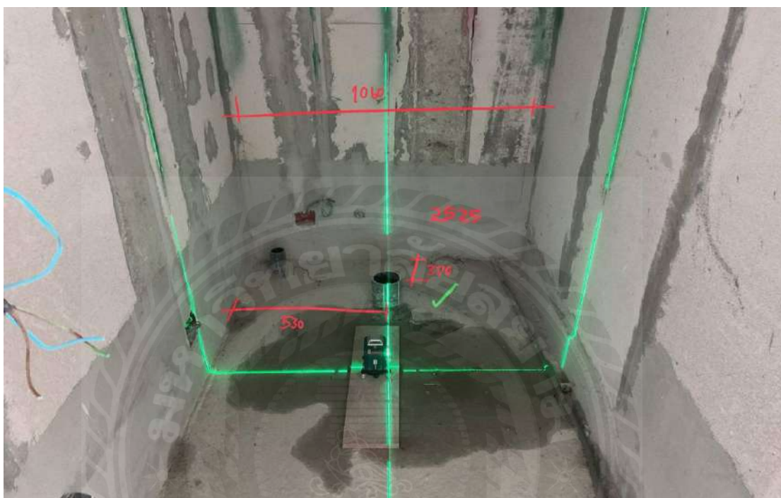
รูปที่ 3.9 รุท่อโสโครกหลังจากติดตั้งเสร็จ
