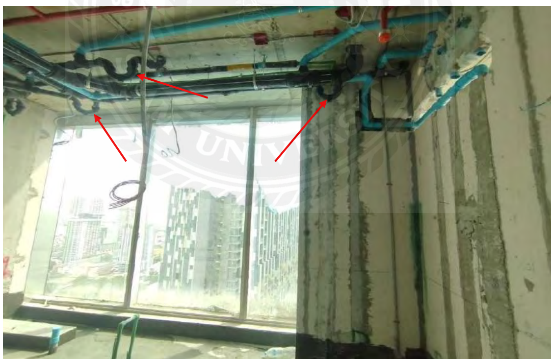
รูปที่ 3.13 อุปกรณ์ P-Trap ของห้องอาบน้ำ
