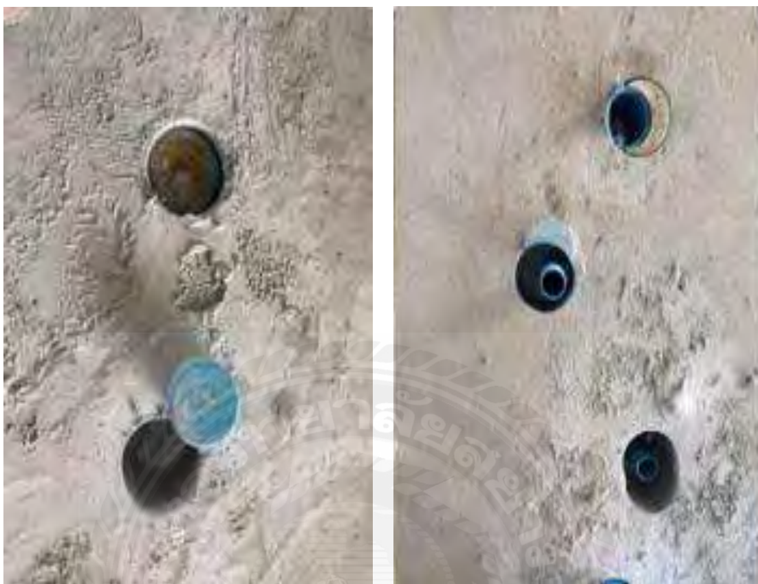
รูปที่ 3.23 การวางสลีฟ ที่ผิดไปจากแบบแปลน
