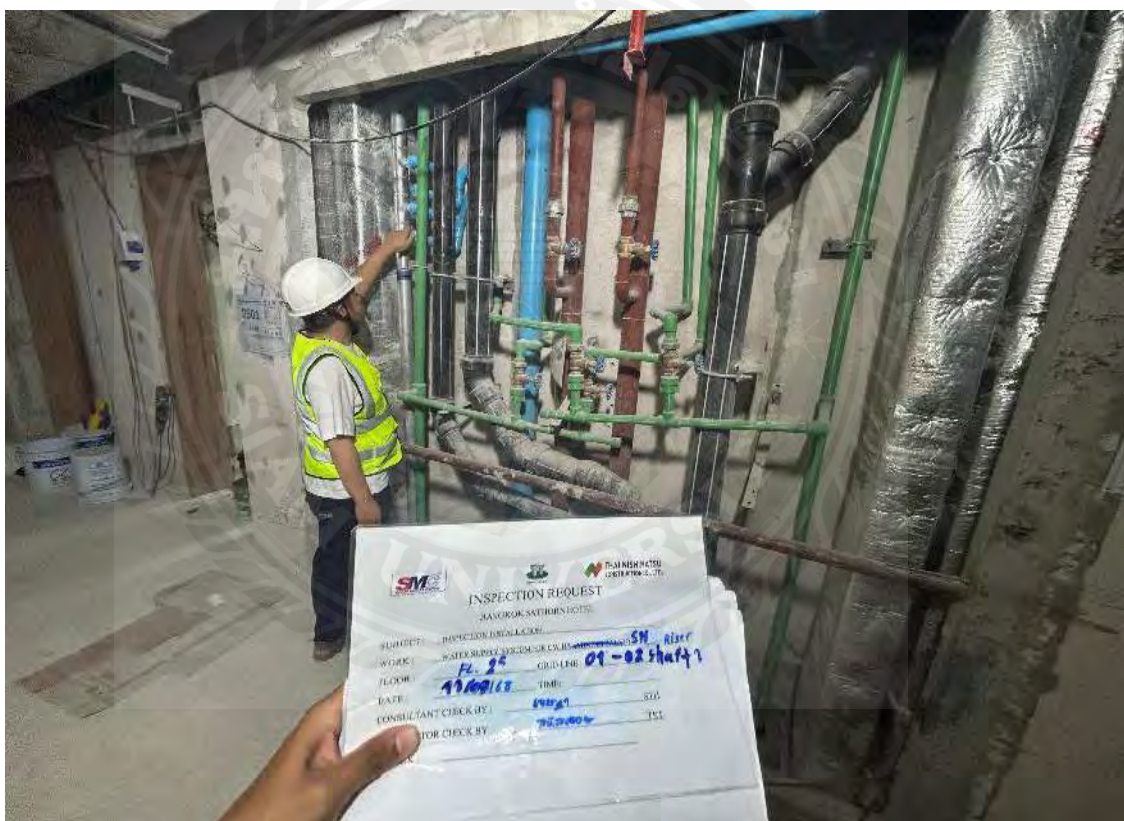
รูปที่ 3.30 การส่งตรวจท่อระบบสุขาภิบาลในแนวดิ่ง
