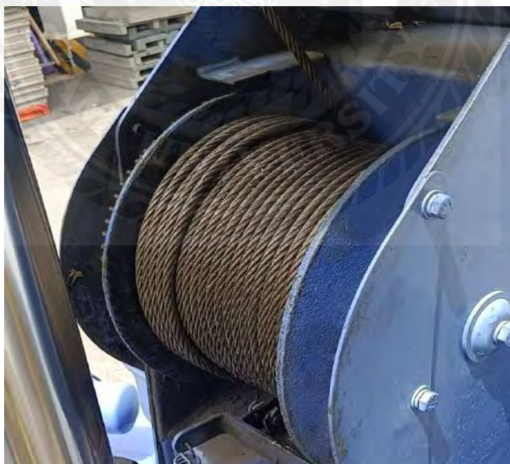
รูปที่ 3.19 การตรวจสอบม้วนสลิง (Rope Drum)
