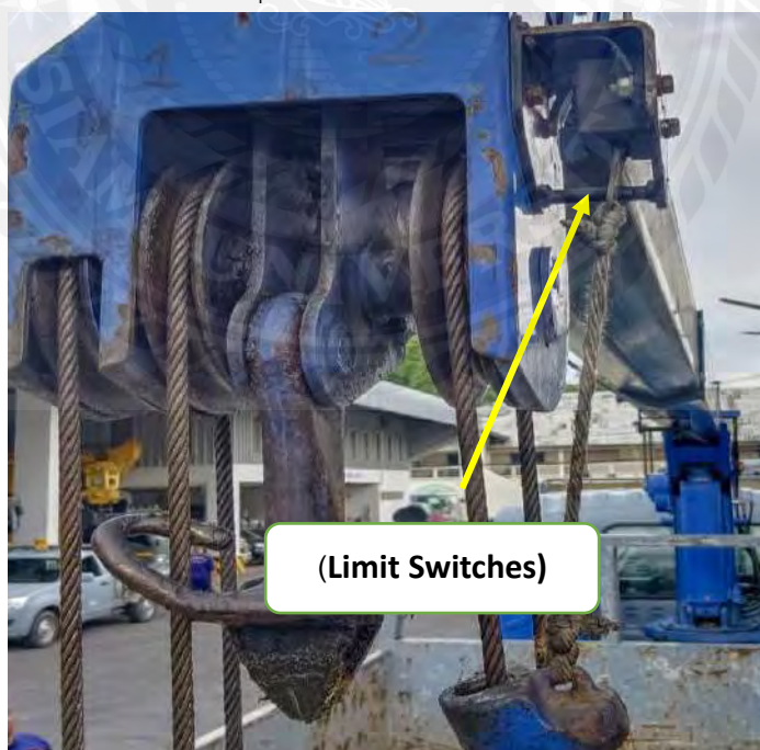
รูปที่ 3.17 การตรวจสอบสวิตช์หยุดการทำงานของปั้นจั่น
