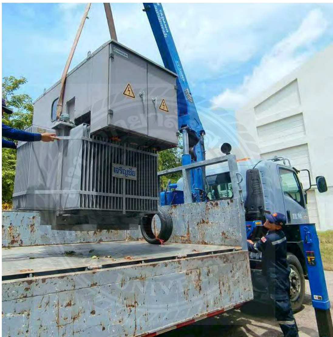
รูปที่ 3.25 การตรวจสอบอุปกรณ์หรือเครื่องมือที่ใช้ในการทดสอบน้ำหนักที่ใช้ทดสอบการยก หม้อ แปลงไฟฟ้า (Electrical transformer) น้ำหนัก 2,760 กิโลกรัม ระบุ วิธีการตรวจสอบแนวเชื่อม ระบุ Close visual check.
