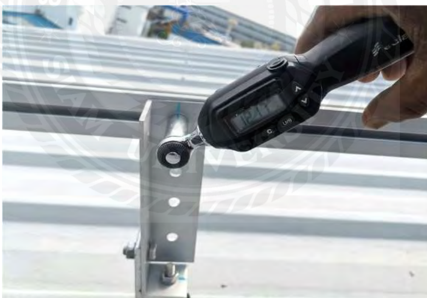
ภาพที่ 3.17 การตรวจสอบแรงบิดของสกรูยึด โครงสร้างแผงโซลาร์เซลล์
