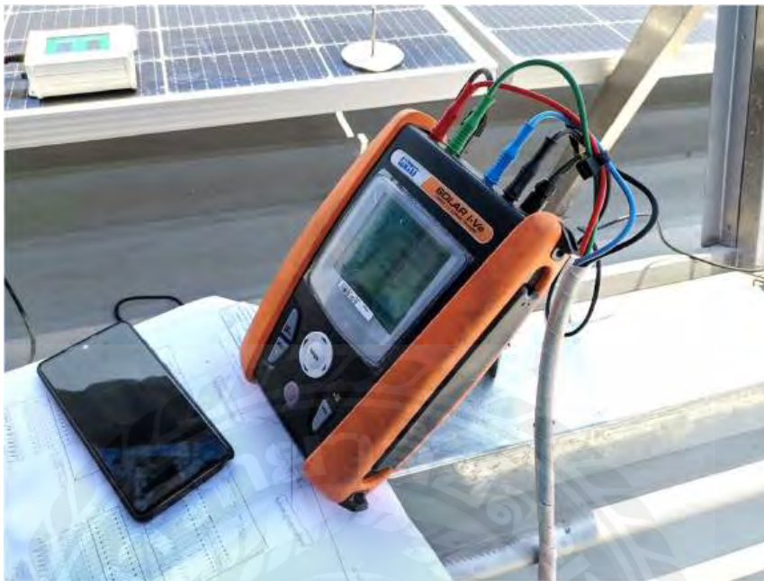
ภาพที่ 3.20 การใช้เครื่องมือ Solar PV Analyzer สำหรับทดสอบและบันทึกค่าประสิทธิภาพของระบบแผงโซลาร์เซลล์ในขั้นตอนการตรวจสอบหน้างาน
