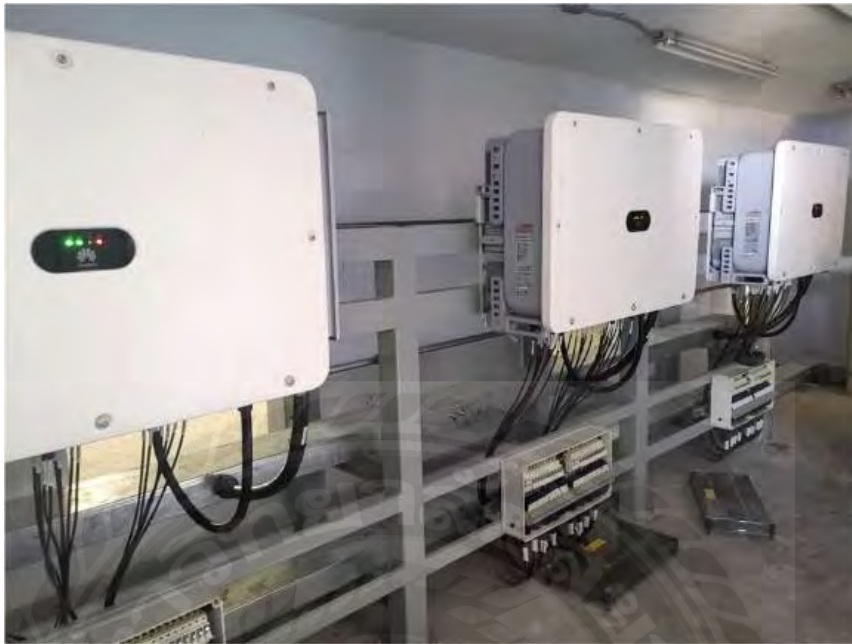
ภาพที่ 3.18 การติดตั้งและตรวจสอบการทำงานของอินเวอร์เตอร์ (Inverter)
