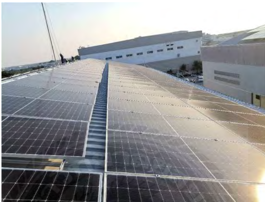
ภาพที่ 3.16 การติดตั้งแผงโซลาร์เซลล์บนหลังคาเมทัลชีท
