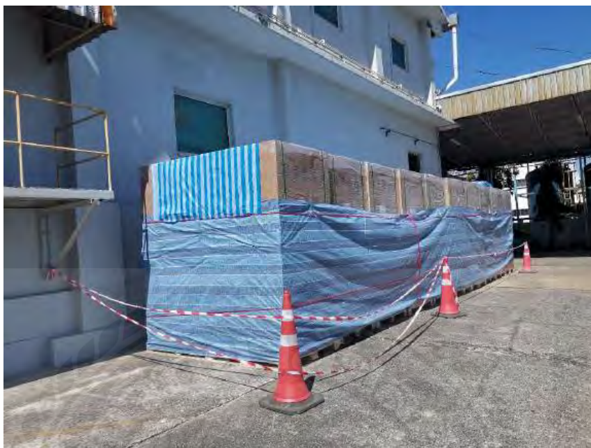
ภาพที่ 3.14 การจัดเก็บและกั้นเขตวัสดุแผงโซลาร์เซลล์ในพื้นที่โครงการ
