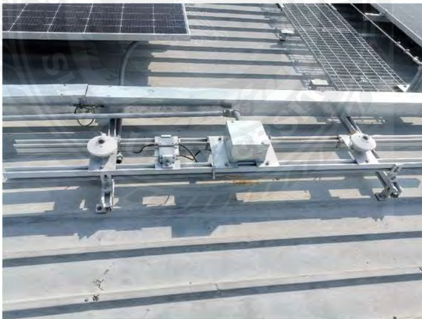
ภาพที่ 3.19 การติดตั้งอุปกรณ์วัดรังสีอาทิตย์ (Pyranometer) และกล่องพักสายบนหลังคา
