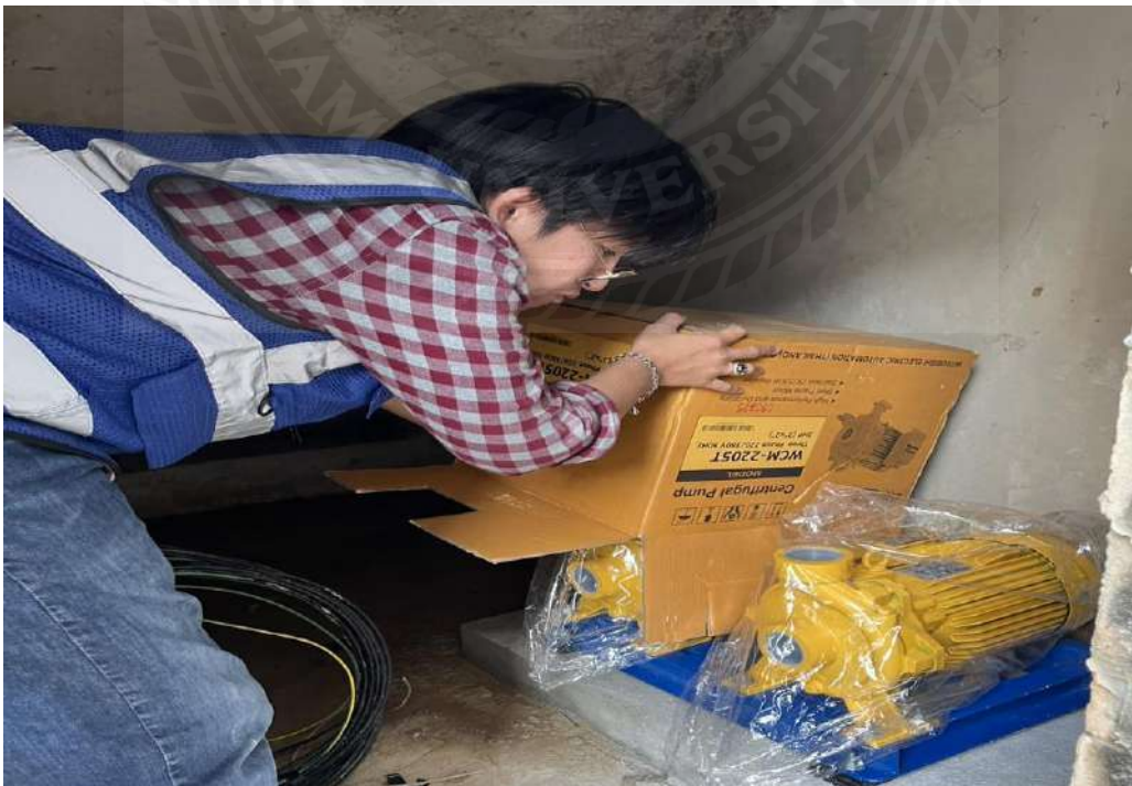
รูปภาพผนวกที่ 6 การติดตั้งปั้มน้ำลงบนฐาน
