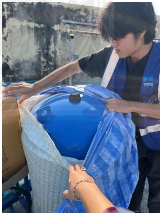
รูปที่ 3.29 การตรวจสอบสภาพถังแรงดัน
