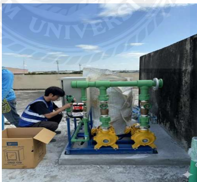
รูปที่ 3.25 การติดตั้งปั้มน้ำ
