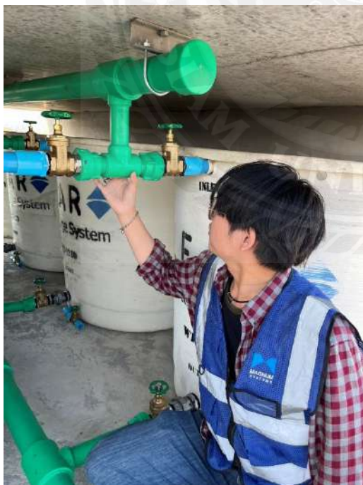
รูปที่ 3.28 การตรวจสอบวาล์วและข้อต่อ
