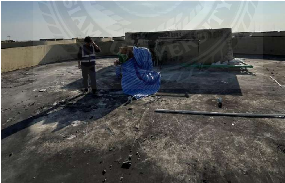
รูปภาพผนวกที่ 4 ตรวจสอบพื้นที่ก่อนการติดตั้ง
