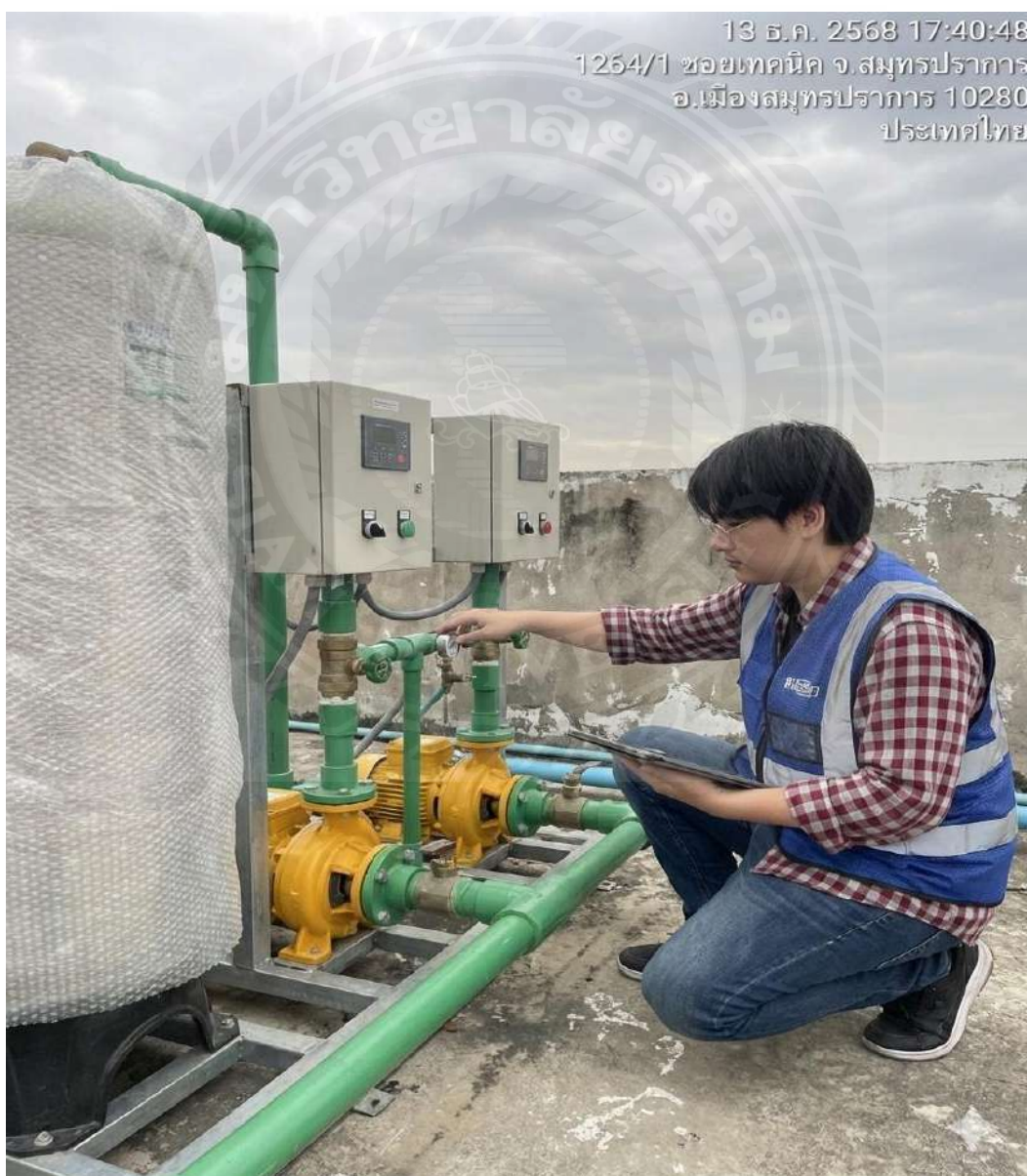
รูปที่ 4.2 ตรวจสอบการติดตั้งของปั้มน้ำ
