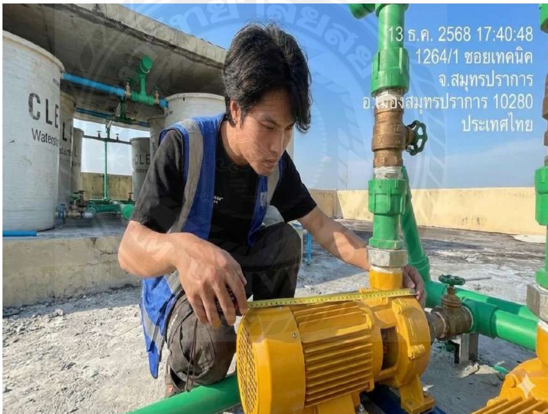
รูปที่ 4.1 การตรวจสอบและการติดตั้งระบบปั้มน้ำบนชั้นดาดฟ้า
