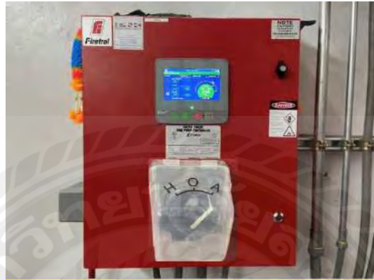
รูปที่ 3.26 Selector Switch แบบ Automatic
