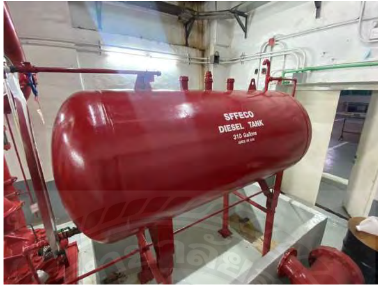
รูปที่ 3.21 Oil Tank เครื่องสูบน้ำดับเพลิง
