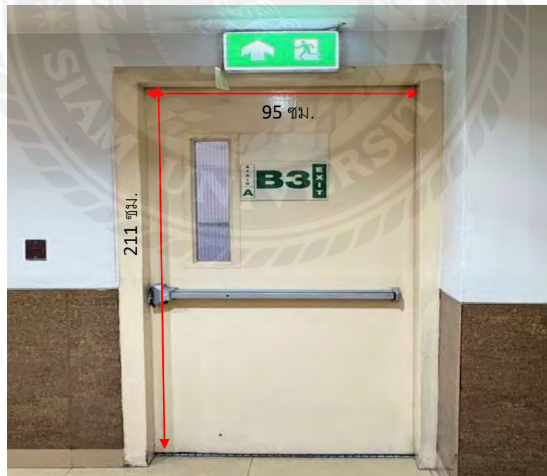
รูปที่ 3.17 ประตูหนีไฟมีความกว้าง 89 ซม. และ ความสูง 209 ซม.
