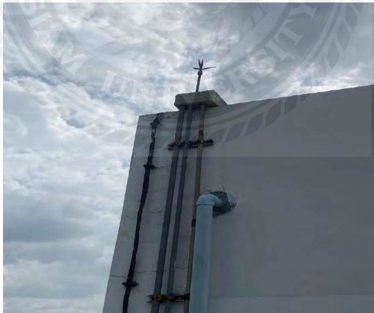
รูปที่ 3.29 การตรวจสอบระบบตัวนำล่อฟ้า
