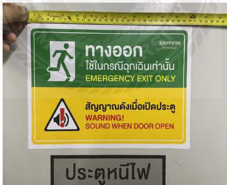
รูปที่ 3.11 การวัดขนาดป้ายบอกทางหนีไฟ
