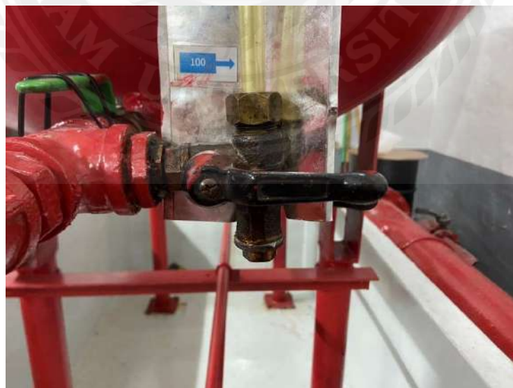
รูปที่ 3.22 วาล์วของ Oil Tank
