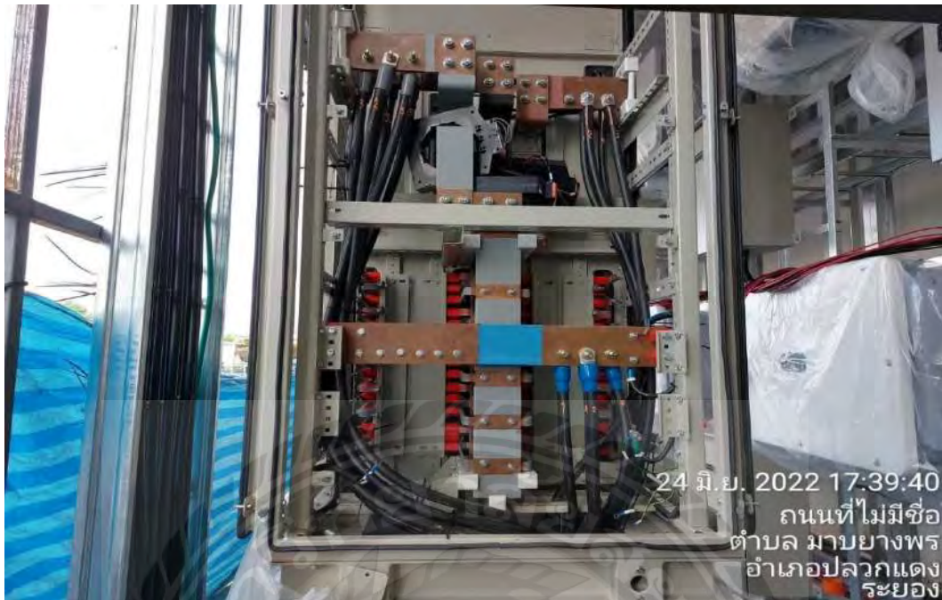
รูปที่ ค 15 เดินสายไฟ AC เข้าตู้
