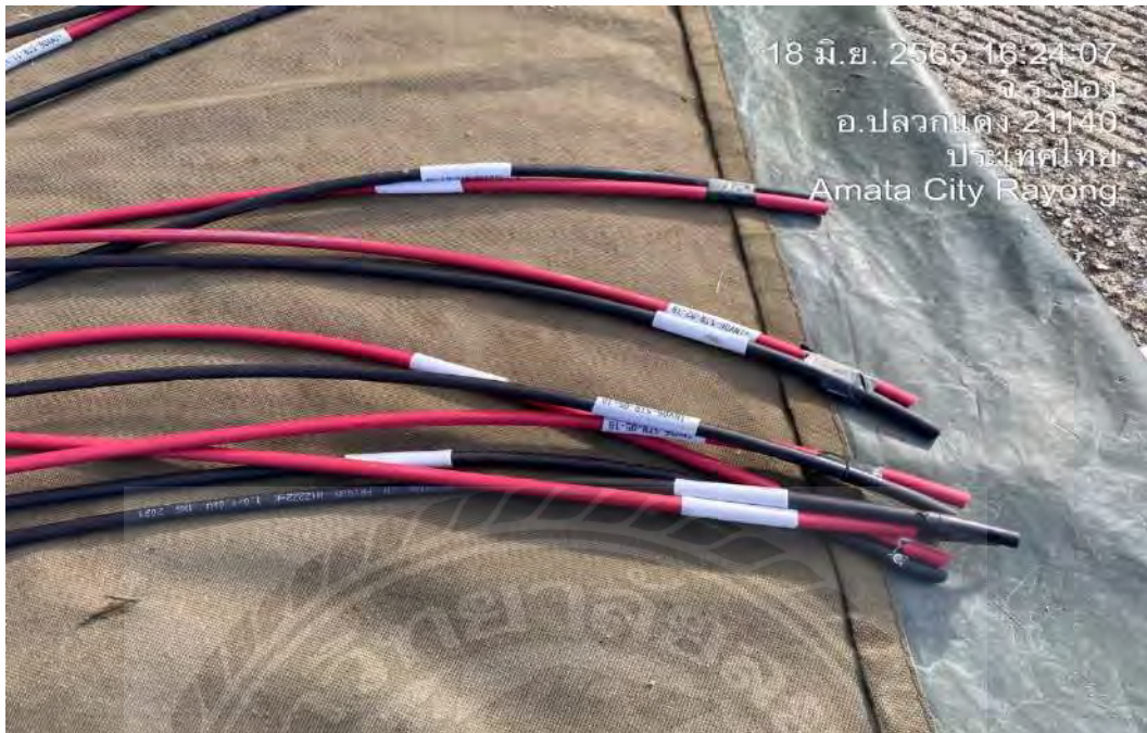
รูปที่ ค 13 มาร์คสายไฟทั้งของ DC และ AC
