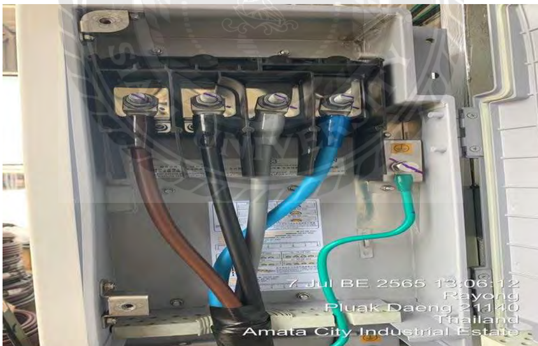
รูปที่ ค 24 เข้าสายไฟของตู้ Inverter
