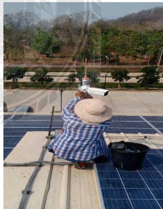
รูปที่ ค 19 Environment Sensor
