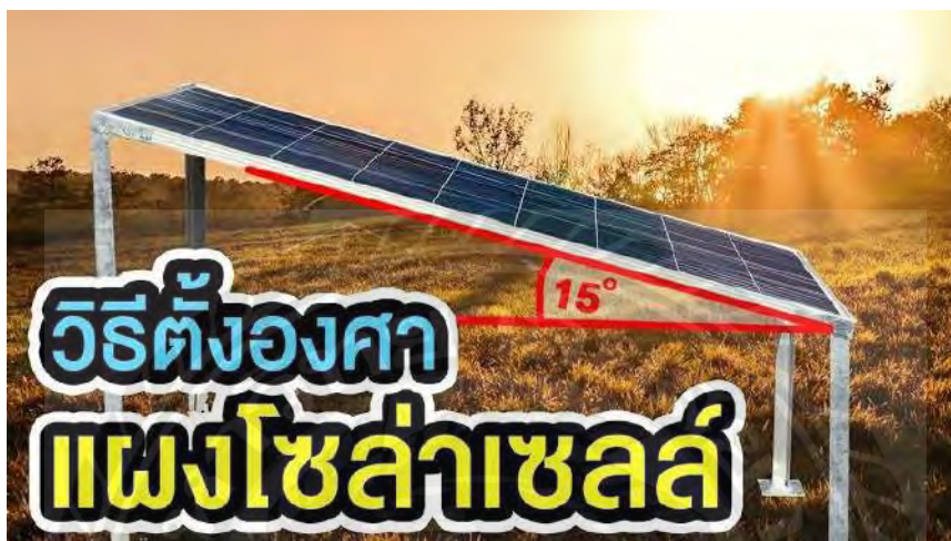
รูปที่ 2.16 ตัวอย่างวิธีตั้งองศาแผงโซล่าเซลล์
