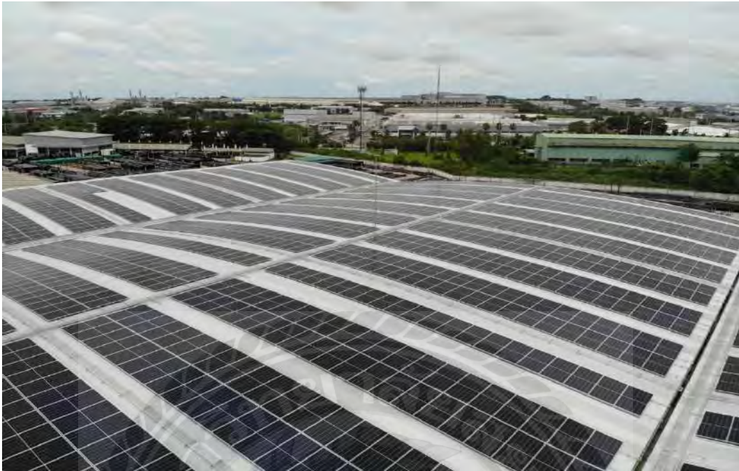
รูปที่ ค 31 ภาพการติดตั้งแล้วเสร็จ Solar Rooftop 999.990 kWp
