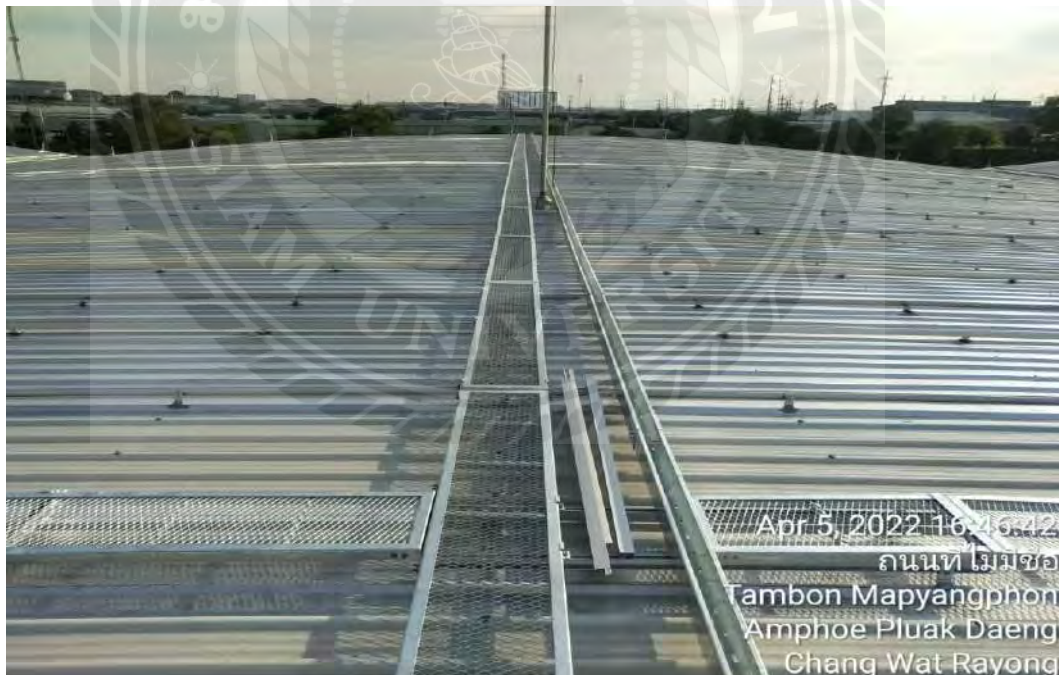
รูปที่ ค 3 การติดตั้งอุปกรณ์เม้าตัง (Mounting)
