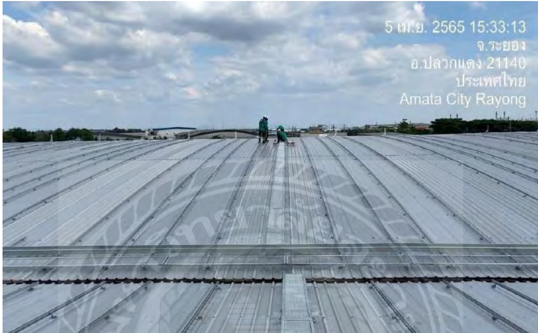
รูปที่ 4.8 ติดตั้งโครงสร้างรับน้ำหนัก
