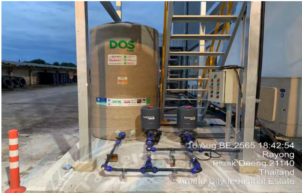
รูปที่ ค 25 ระบบทำความสะอาดแผ่น
