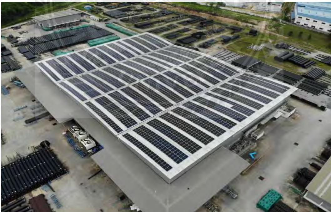
รูปที่ ค 32 ภาพมุมสูงการติดตั้งแล้วเสร็จ Solar Rooftop 999.990 kWp
