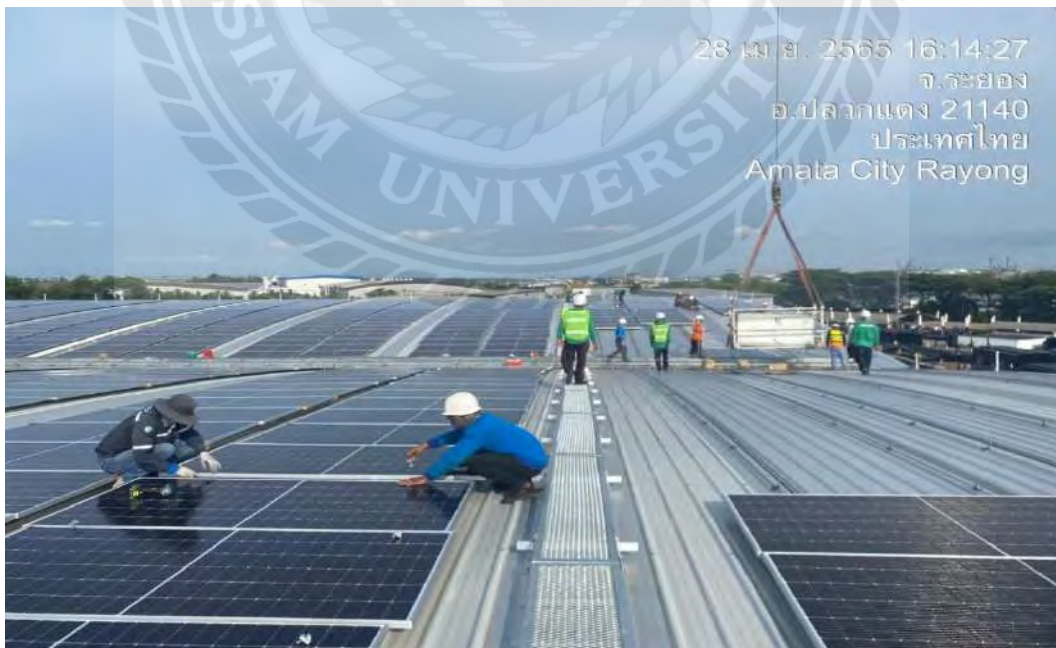
รูปที่ 4.9 ติดตั้งแผงโซล่าเซลล์ตามแบบแปลน
