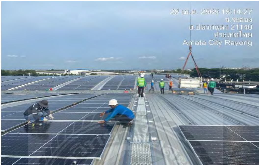
รูปที่ ค 7 ติดตั้ง (PV module)
