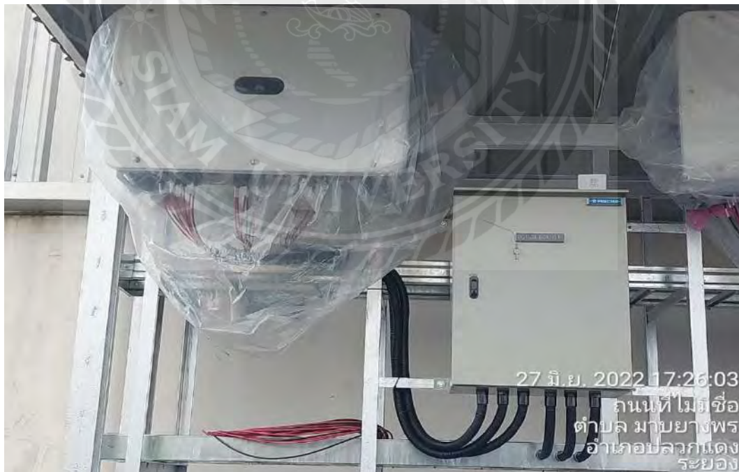
รูปที่ ค 10 ติดตั้ง Inverter
