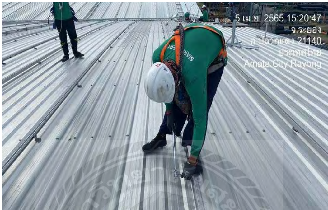
รูปที่ ค 23 Torque น๊อตจับยึดแผงโซล่าเซลล์
