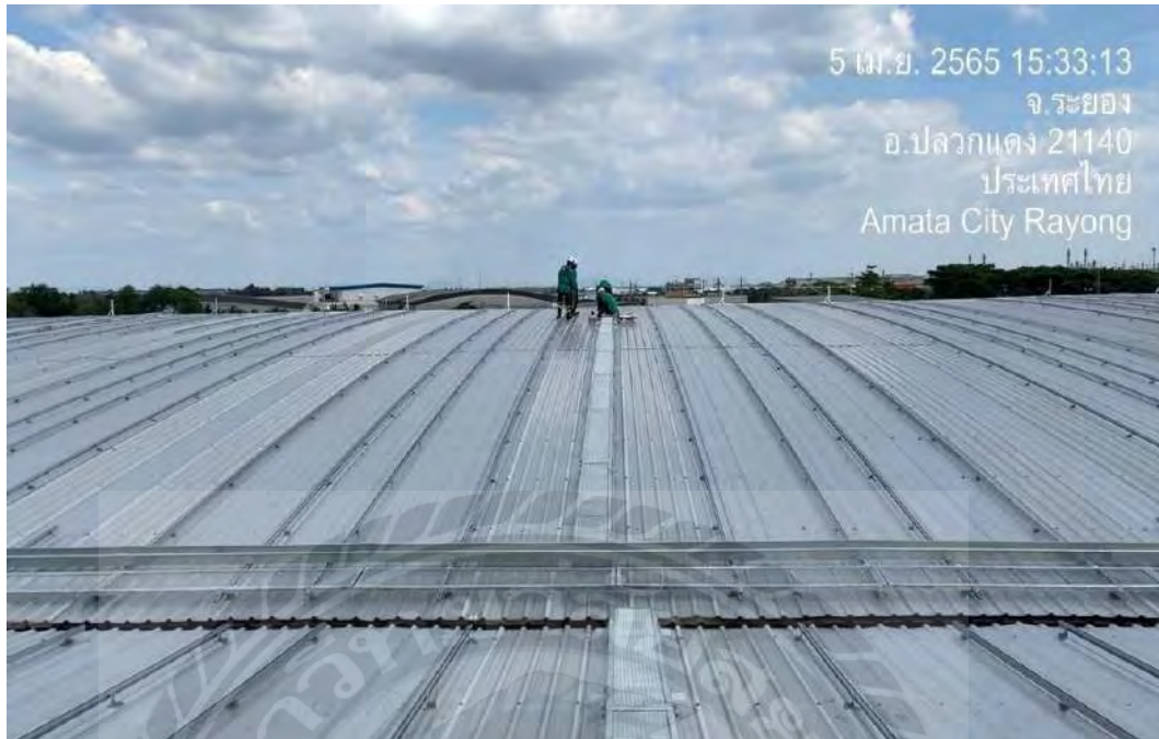
รูปที่ ค 3 การติดตั้งอุปกรณ์เม้าตัง (Mounting)
