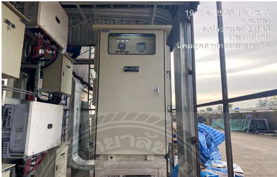
รูปที่ ค 9 ติดตั้งตู้ (PV MDB)
