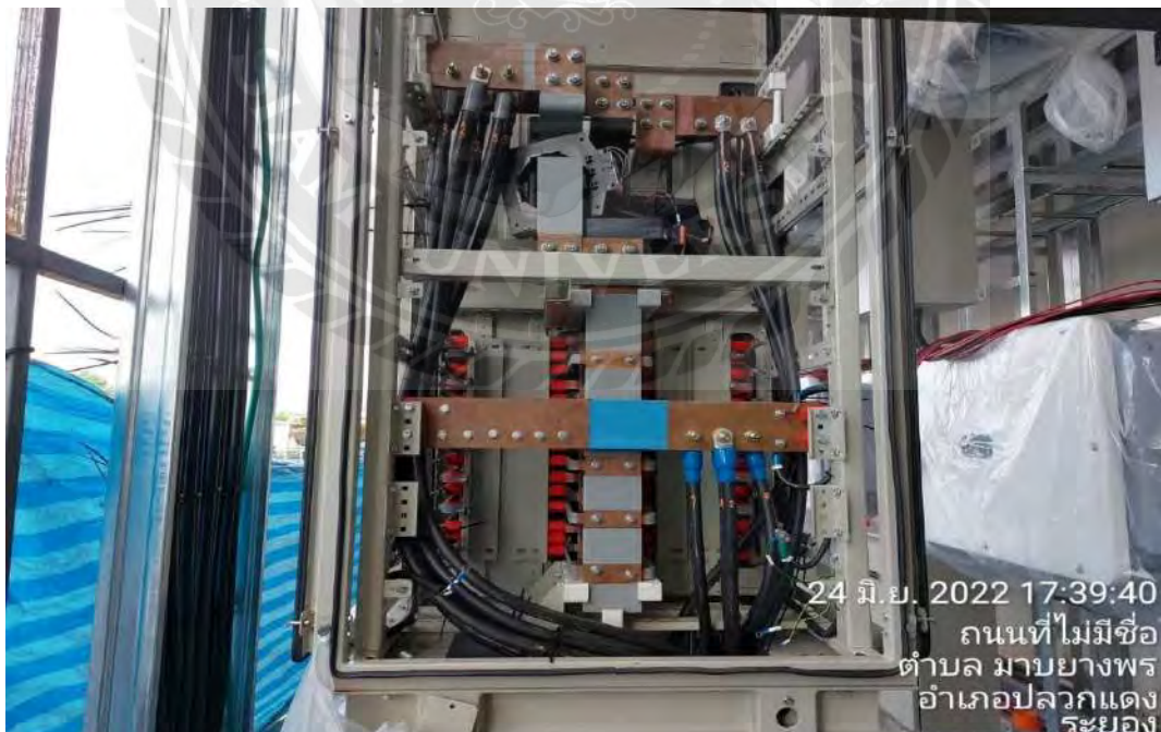
รูปที่ 4.13 เดินสายไฟไปยังตู้ควบคุม
