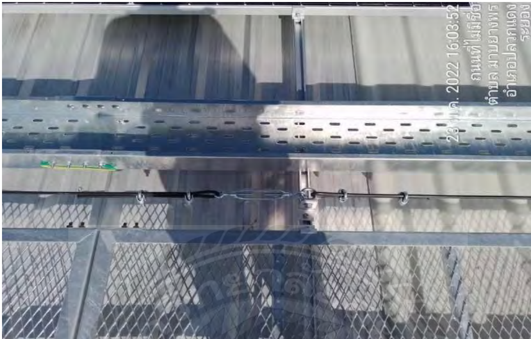
รูปที่ ค 5 รางเคเบิลเทรย์ (Cable Tray)
