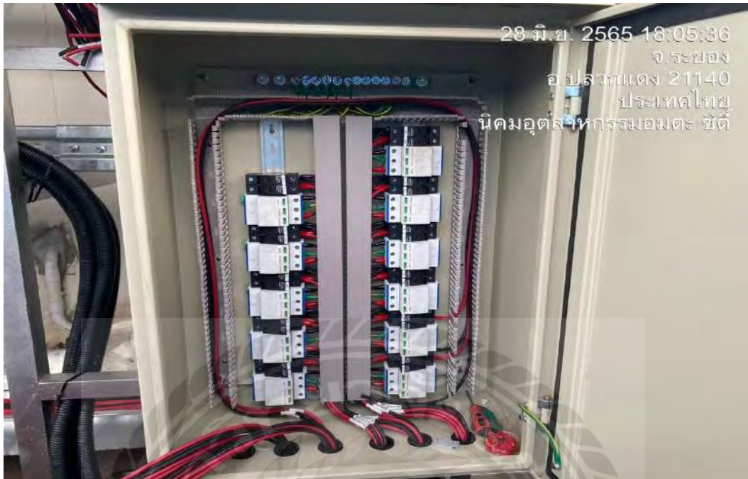
รูปที่ ค 11 ติดตั้ง ตู้ DC บล็อกพิวส์
