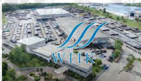
รูปที่ 3.3 สถานที่ปฏิบัติงาน
