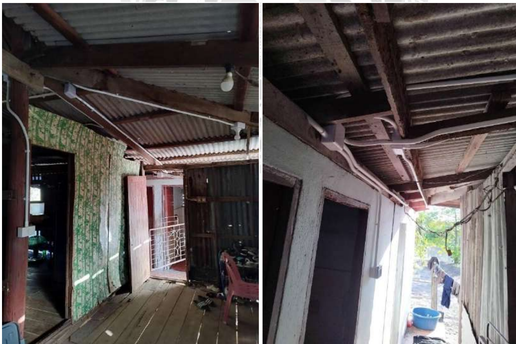
รูปที่ 4.26 แนวท่อของกล่องวงจรปิด-2
