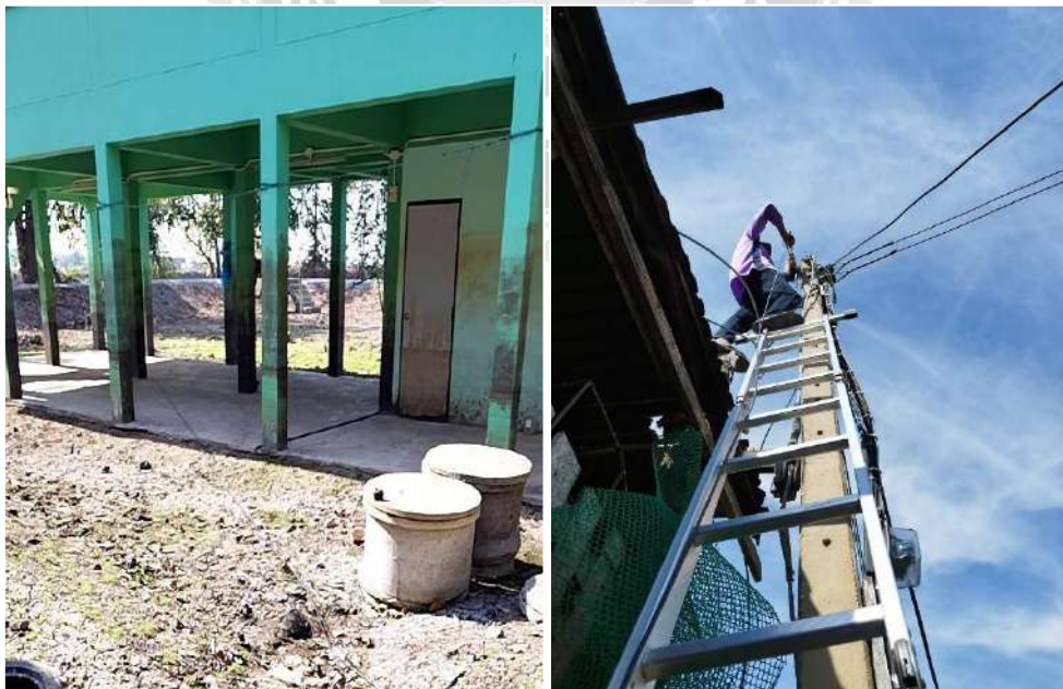
รูปที่ 4.20 การลากสายเมนหลักจากการไฟฟ้า
