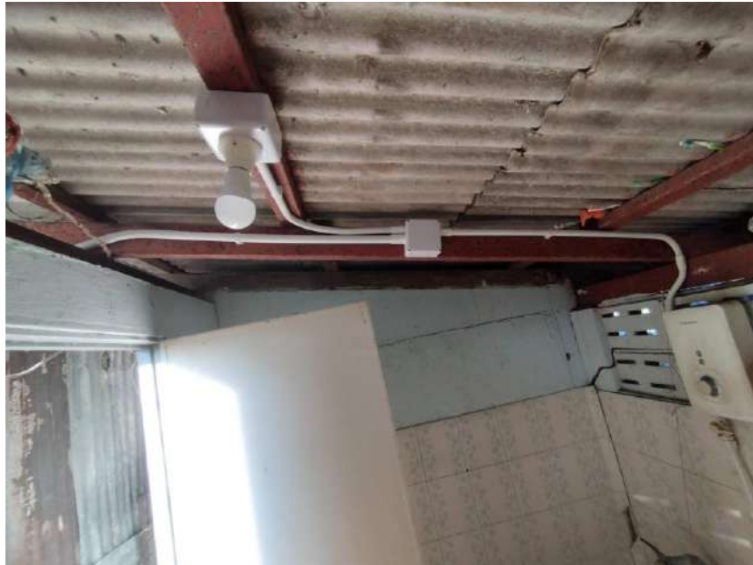
รูปที่ 4.12 แนวท่อในห้องน้ำ
