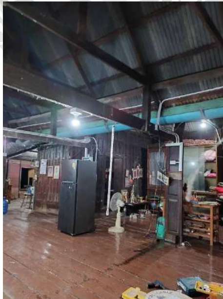
รูปที่ 4.32 การทดสอบระบบไฟฟ้าวงจรใหม่
