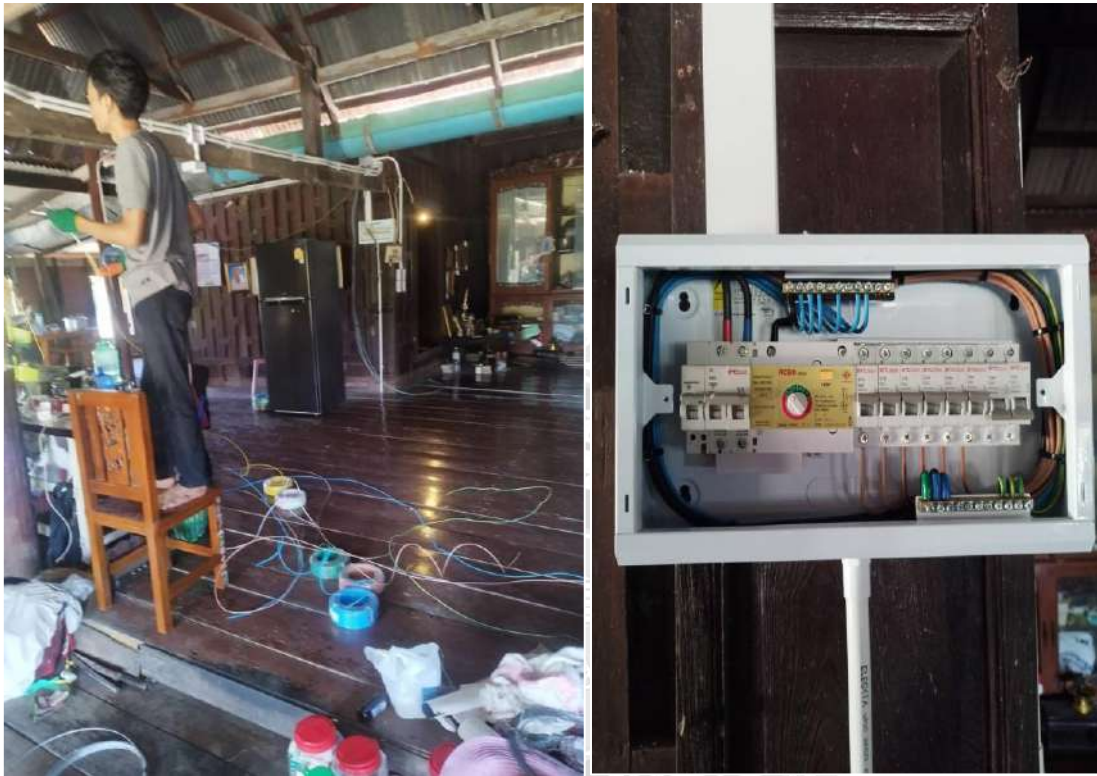
รูปที่ 4.18 การร้อยสายไฟฟ้า
