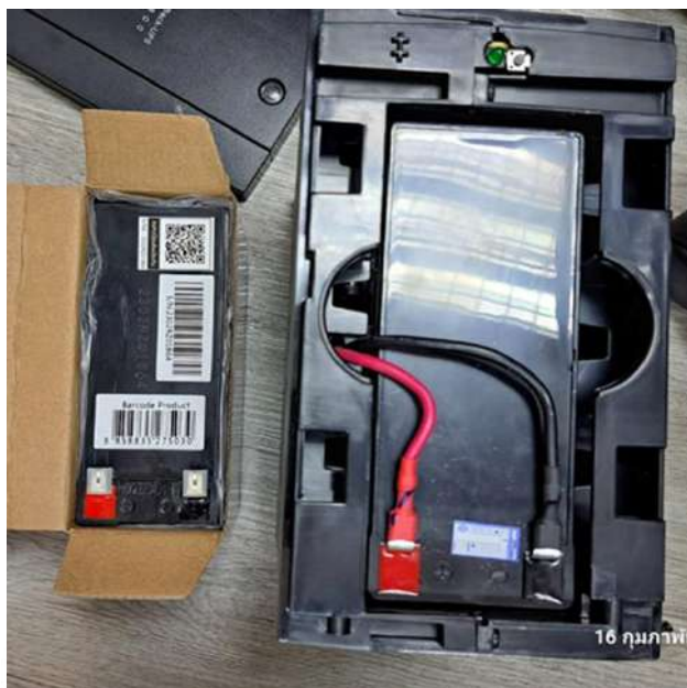
รูปที่ 4.45 การเปลี่ยนแบตเตอรี่ UPS
