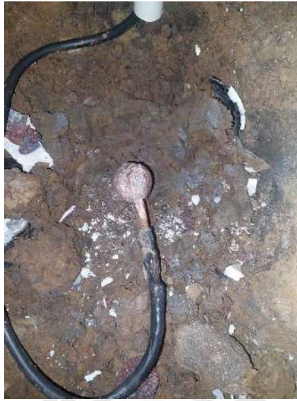
รูปที่ 4.23 การหลอมแท่งกราวด์สมบูรณ์
