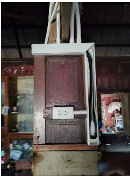
รูปที่ 4.29 การร้อยสายเสร็จสมบูรณ์
