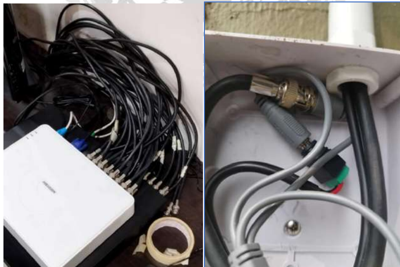
รูปที่ 4.44 การตรวจเช็คสายสัญญาณกล่องวงจรปิด
