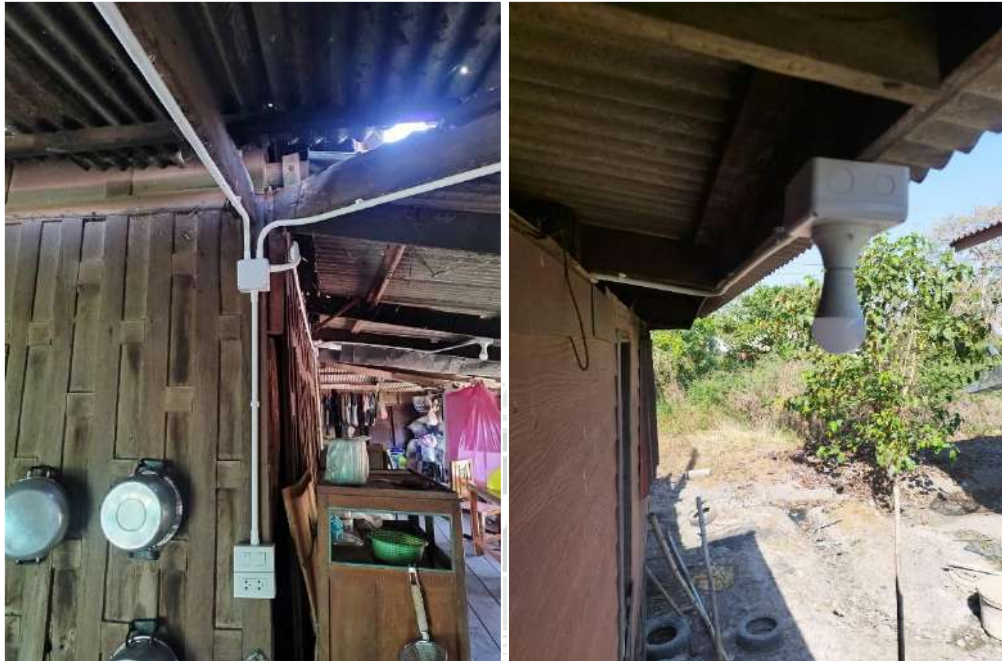
รูปที่ 4.16 แนวท่อโซนที่ล้างจาน
