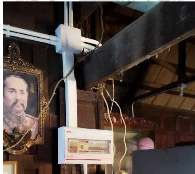
รูปที่ 4.7 การติดตั้งตู้คอนซูเมอร์
