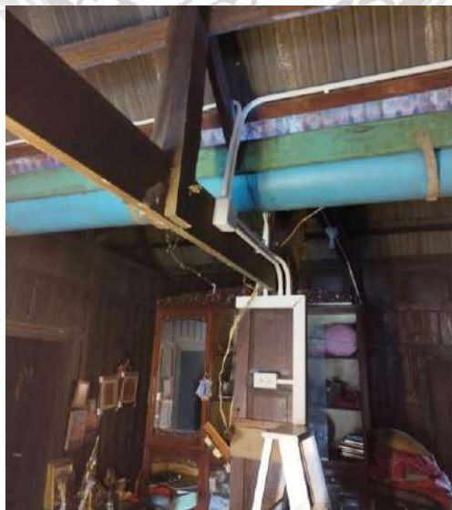
รูปที่ 4.24 จุดตั้งเครื่องบันทึก
