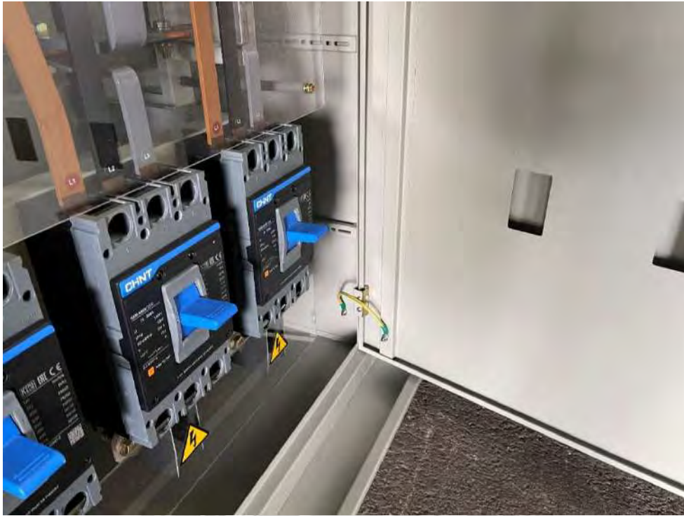
รูปที่ 4.21 ตู้ MDB 800A สายต่อฝากฝาคู่ชั้นใน ด้านล่าง
