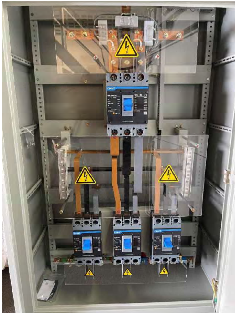
รูปที่ 4.18 ตู้ MDB 800A ติดตั้งแผ่นอะคริลิกใส
