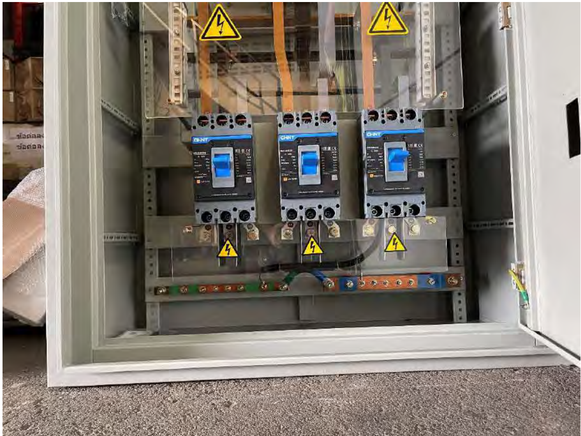
รูปที่ 4.20 ตู้ MDB 800A ติดตั้งบาร์กราวด์ บาร์นิวตรอน
