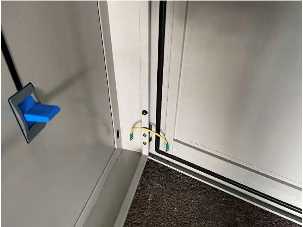
รูปที่ 4.23 ตู้ MDB 800A สายต่อฝาฝ้าตู้ชั้นนอก
