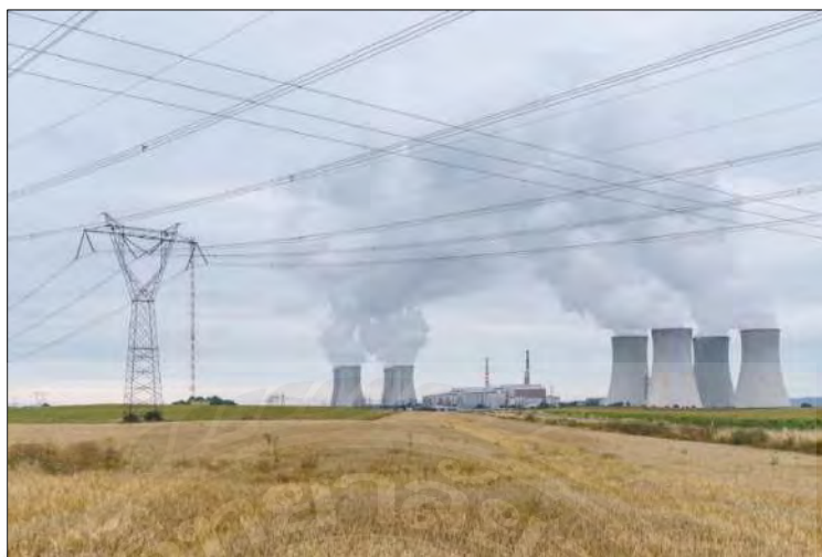
รูปที่ 2.6 หอหล่อเย็น (Cooling Tower)
