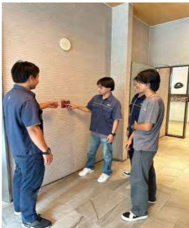
รูปที่ 4.2.6 ตรวจสอบเช็คสัญญาณเตือนไฟไหม้แบบมือ
