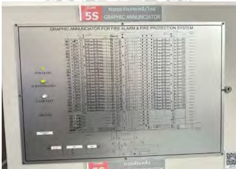
รูปที่ 4.2.3 เซ็คตู้แสดงสถานะเหตุไฟไหม้ในแต่ละชั้น
