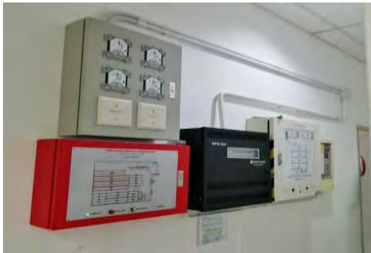
รูปที่ 2.35 ระบบสัญญาณเตือนอัคคีภัย
