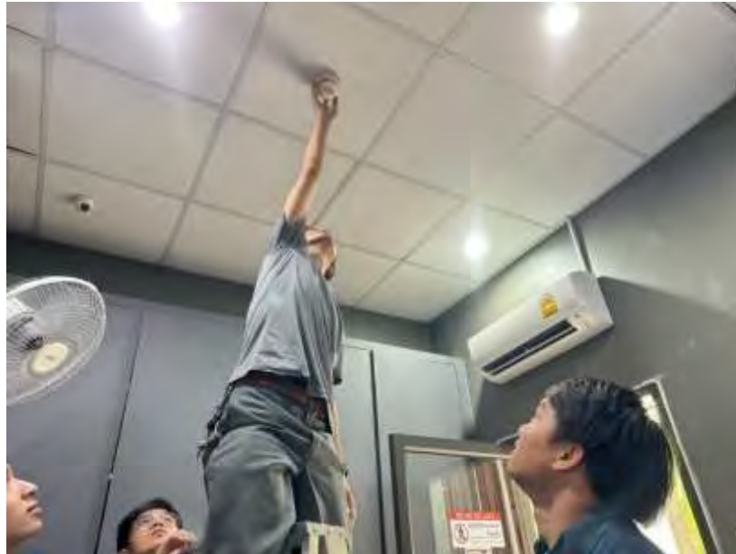
รูปที่ ก 5 ตรวจสอบอุปกรณ์จับควัน
