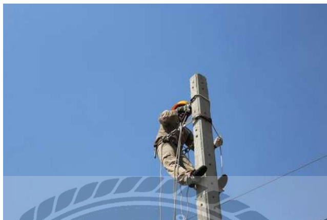
รูปที่ 4.2.6 ติดตั้งอุปกรณ์บนเสา
