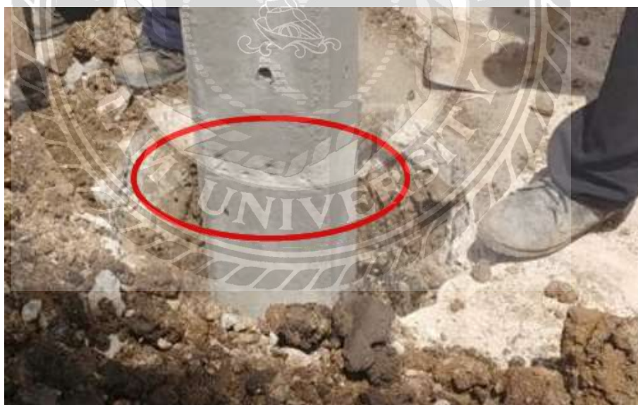
รูปที่ 2.16 จุดแสดงความลึกในการปักเสา
