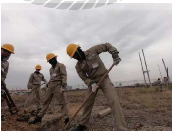
รูปที่ 4.2.3 การขุดหลุมเสา
