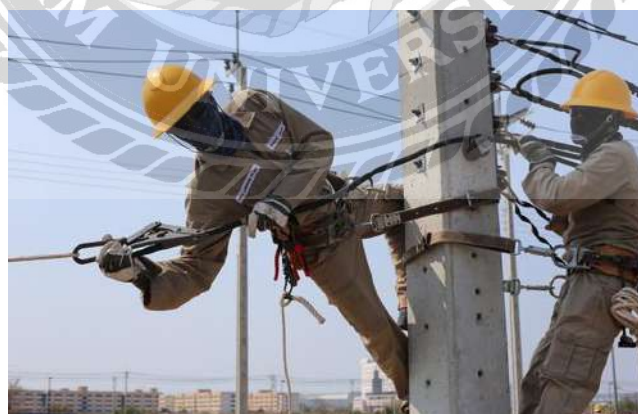
รูปที่ 4.2.7 การพาดสายไฟฟ้า
