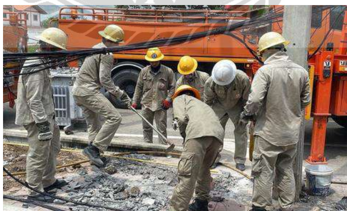
รูปที่ 4.2.5 การกลบดินและบดอัด
