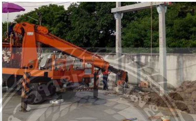
รูปที่ 4.2.4 การตั้งเสาไฟฟ้า
