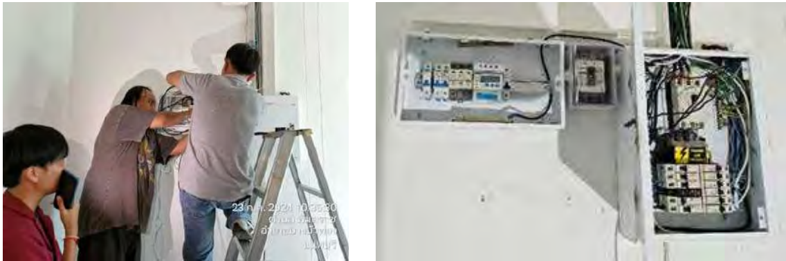
รูปที่ 4.9 การติดตั้งตู้คอนซูมเมอร์ยูนิต (Consumer Unit)
