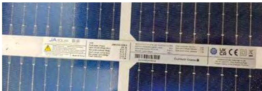
รูปที่ 4.2 Name Plate ของแผงพลังงานแสงอาทิตย์ในโครงการ
