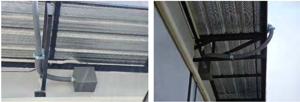
รูปที่ 4.5 การติดตั้งท่อโลหะอ่อนกันน้ำ (Liquid Flexible Metal Conduit) เพื่อเดินสายไฟฟ้าจากแผงพลังงานแสงอาทิตย์มายังภายในอาคาร
