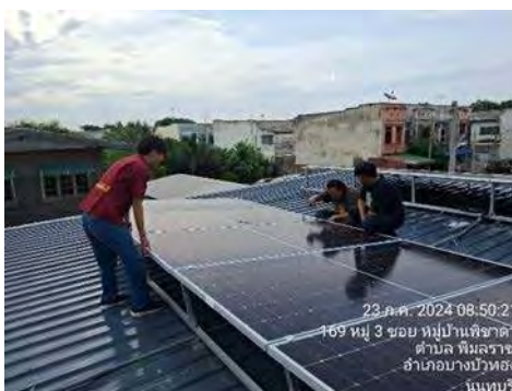
รูปที่ 4.7 การต่อสายไฟฟ้าของแผงพลังงานแสงอาทิตย์เข้าด้วยกัน
