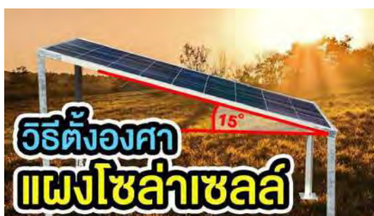
รูปที่ 2.6 การตั้งแผงโซลาร์เซลล์เอียงทำมุม 15 องศา
