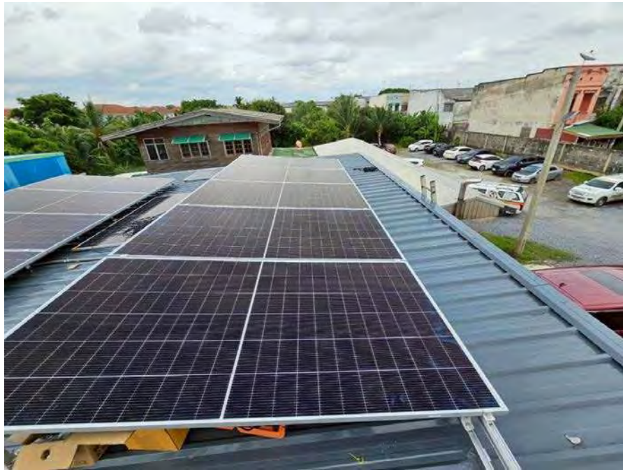
งานติดตั้งแผงพลังงานแสงอาทิตย์ที่เสร็จสมบูรณ์
