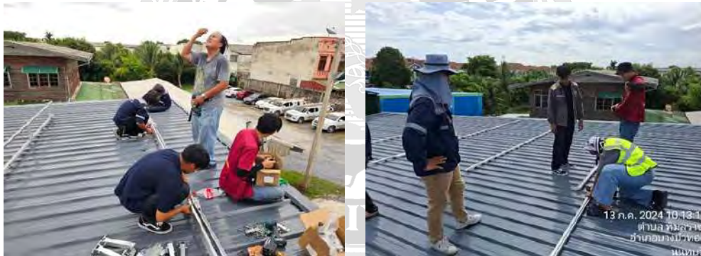
รูปที่ 4.3 การติดตั้ง L-Foot เพื่อยึดรางกับหลังคาเมทัลชีท
