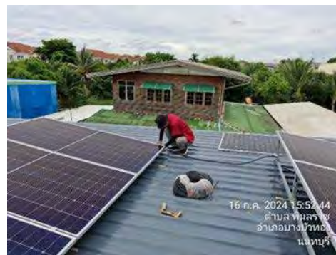
รูปที่ 4.7 การต่อสายไฟฟ้าของแผงพลังงานแสงอาทิตย์เข้าด้วยกัน
