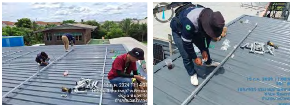
รูปที่ 4.4 การติดตั้งรางอลูมิเนียม (Rail) ยึดเข้ากับ L-Foot
