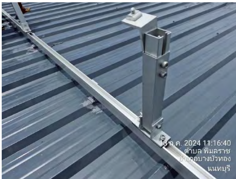
การติดตั้งขาตั้งปรับระดับแผงพลังงานแสงอาทิตย์
