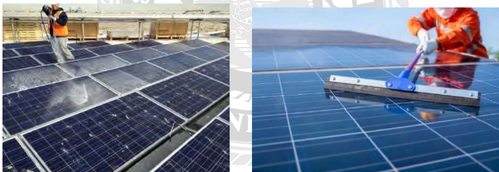
รูปที่ 2.43 การทำความสะอาดแผงโซลาร์เซลล์
