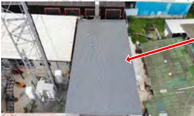
พื้นที่ติดตั้งแผงพลังงานแสงอาทิตย์
