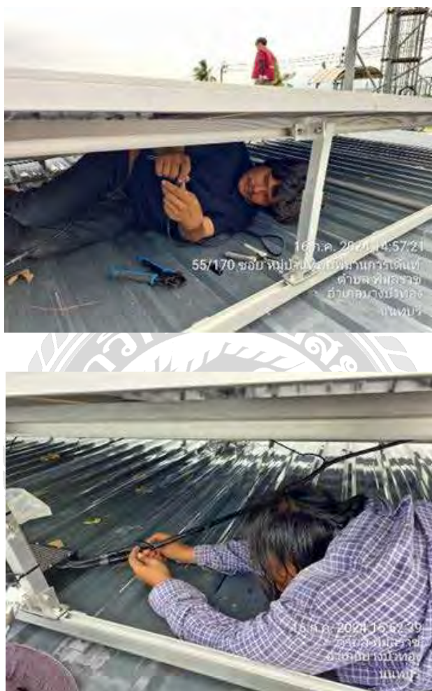
รูปที่ 4.8 การต่อสายไฟจากแผงฯ เข้า Micro Inverter
