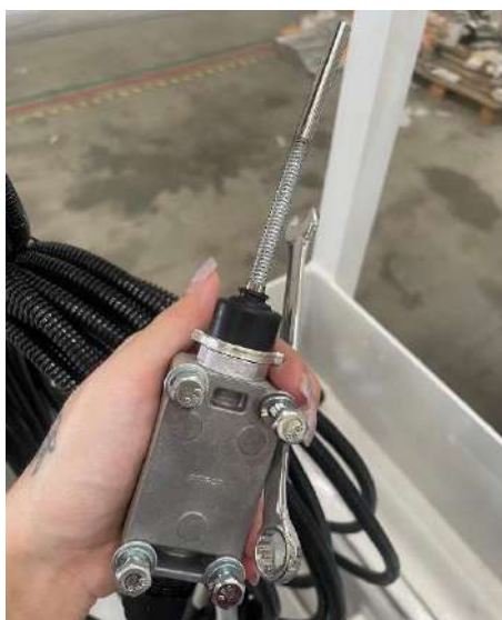
รูปที่ 4.11 การติดตั้งอุปกรณ์เซนเซอร์ความปลอดภัย
