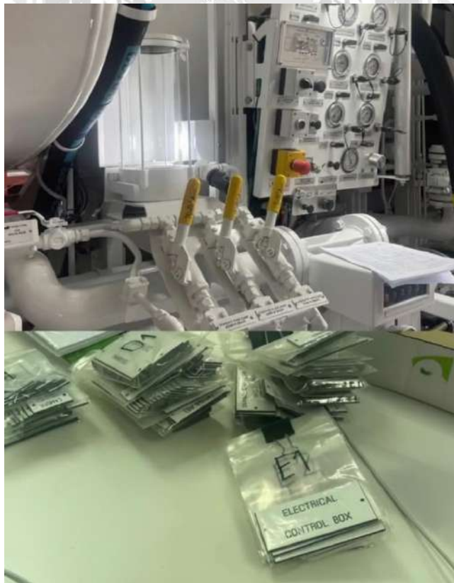
รูปที่ 10 เตรียมป้ายชื่ออุปกรณ์ เพื่อระบุแต่ละตำแหน่งให้ตรงกับเอกสารที่ทำไว้
