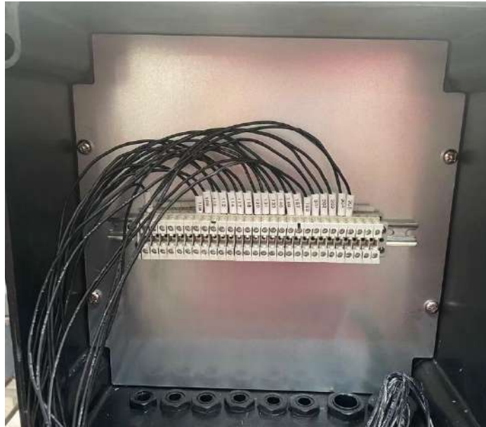
รูปที่ 4.7 การต่อสายไฟเข้ากับเทอร์มินอลบล็อก
