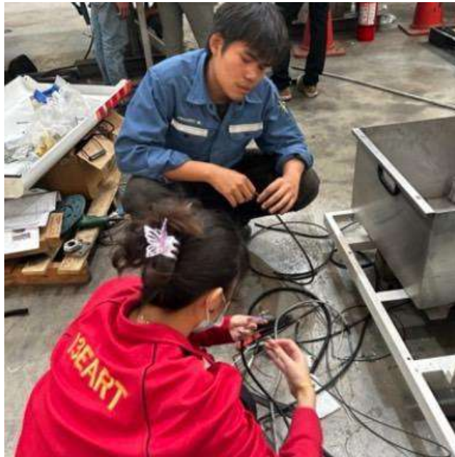
รูปที่ 7 เดินสายไฟและสายควบคุมเข้าตู้คอนโทรล พร้อมย่ำสาย
