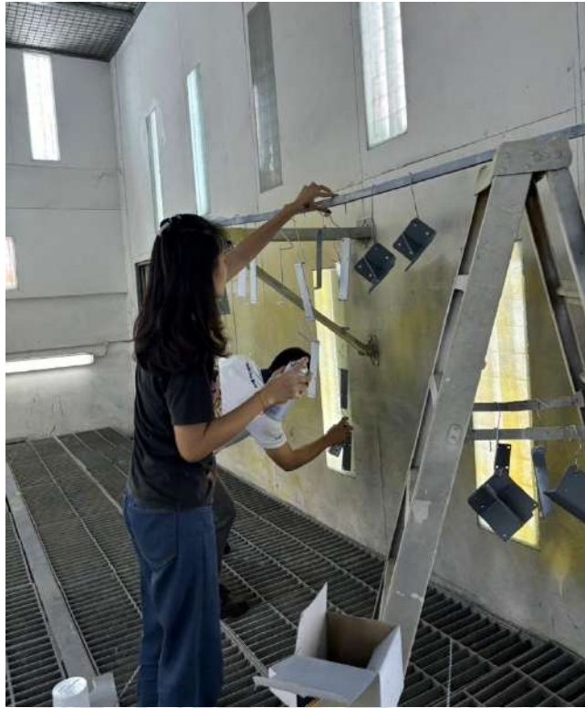
รูปที่ 9 ทาสีเคลือบชิ้นส่วนเหล็ก
