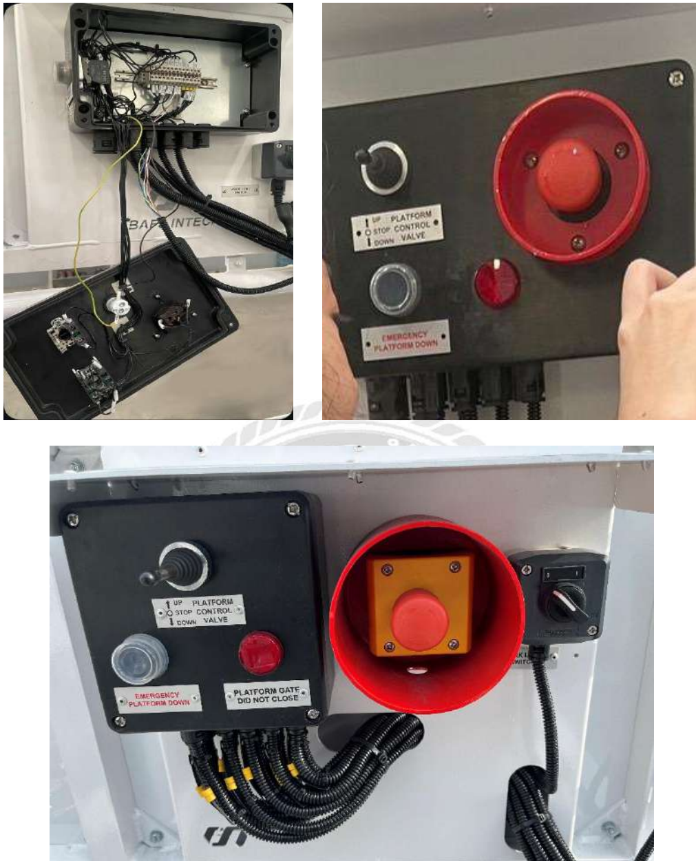
รูปที่ 4.8 การติดตั้งอุปกรณ์ควบคุมและความปลอดภัย
