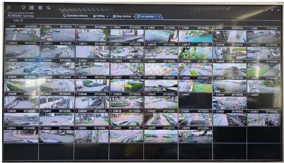
รูปที่ 4.9 กล้องวงจรปิดดับ
