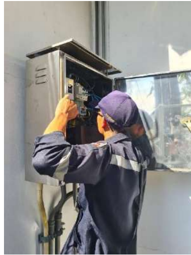
รูปที่ 4.7 ติดตั้งตู้อุปกรณ์และตู้ไฟฟ้า
