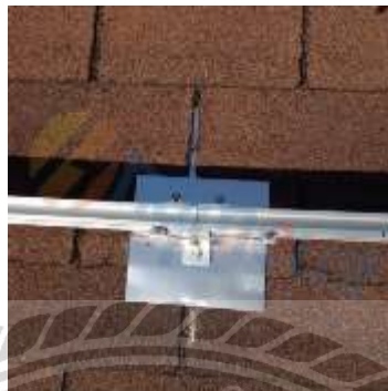
รูปที่ 3.11 ฐานสำหรับติดตั้งแผงโซลาร์เซลล์
