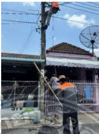
รูปที่4.5 การป็นหย่อนสายไฟฟ้าบนเสาไฟ
