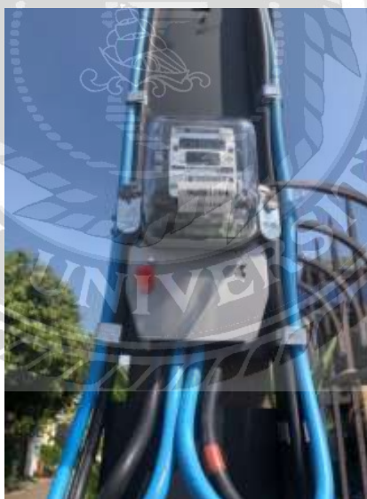
รูปที่ 2.5 สายไฟ THW 35 แยกสี ฉนวน 1 ชั้น
