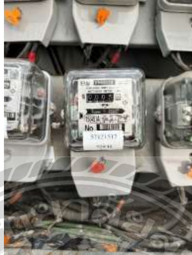
รูปที่4.3 การจดบันทึกตรวจสอบข้อมูลมิเตอร์เก่า
