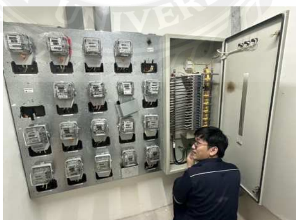
รูปที่ 2.3 การ PM ระบบไฟฟ้า
