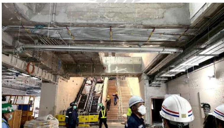
ภาพที่ 3.35 ตรวจเยี่ยมด้านความปลอดภัยฯ (Day Audit) โครงการก่อสร้างรถไฟฟ้าขนส่งมวลชน สายสีม่วง (ใต้)
