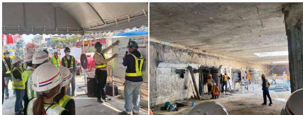
ภาพที่ 3.18 ตรวจเยี่ยมด้านความปลอดภัยฯ (Day Audit) โครงการก่อสร้างรถไฟฟ้าขนส่งมวลชน สายสีม่วง (ใต้) ช่วงเตาปูน-ราษฎร์บูรณะ สัญญาที่ 3 และ 4
