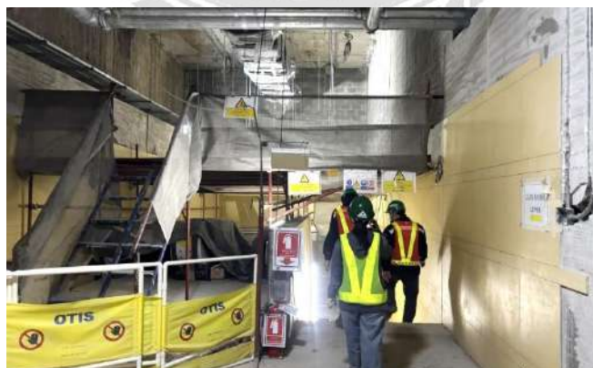
ภาพที่ 3.29 ตรวจเยี่ยมด้านความปลอดภัยฯ (Day Audit) โครงการก่อสร้างรถไฟฟ้าขนส่งมวลชน สายสีม่วง (ใต้) ช่วงเตาปูน-ราษฎร์บูรณะ สัญญาที่ 1 และ 2
