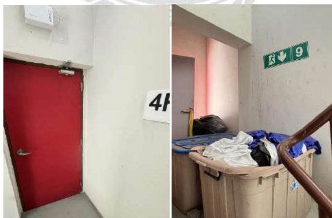
ภาพที่ 3.19 ตรวจสอบความเรียบร้อยของเส้นทางหนีไฟภายในอาคารสำนักงาน
