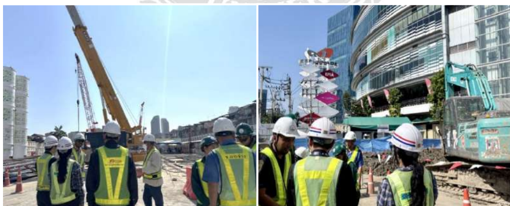
ภาพที่ 3.31 ตรวจเยี่ยมด้านความปลอดภัยฯ (Day Audit) โครงการก่อสร้างรถไฟฟ้าขนส่งมวลชน สายสีส้ม (ตะวันออก)
