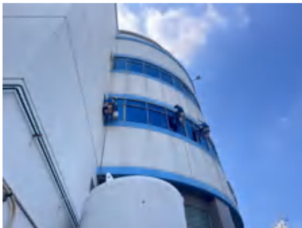
รูปภาพที่ 3.14 ดูเรื่องความปลอดภัยให้ผู้รับเหมาที่ทำงานบนที่สูง
